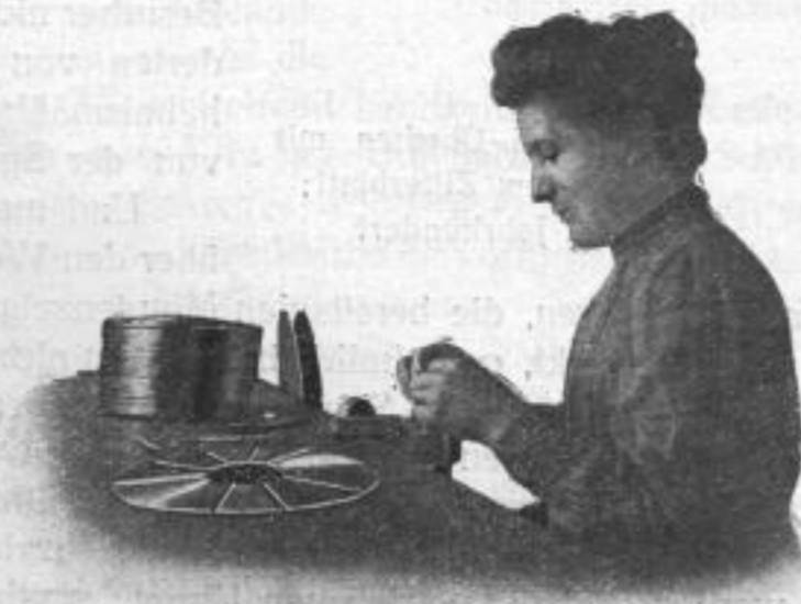
Fig. 3. Das Aufbinden der Federn zum Härten
