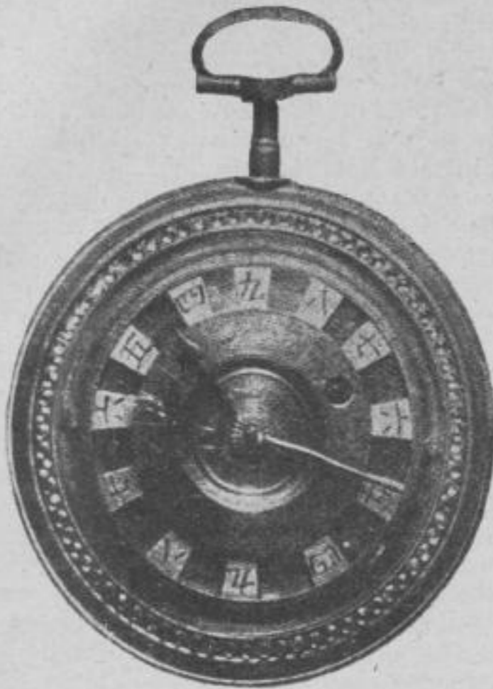
Abb. 4. Alte japanische Uhr mit verschiebbaren Stundenplättchen
