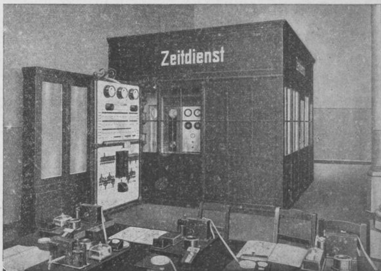
Abb. 27. Zentralraum der Zeitdienstanlagen im Telegraphenzimmer des Schlesischen Bahnhofes
