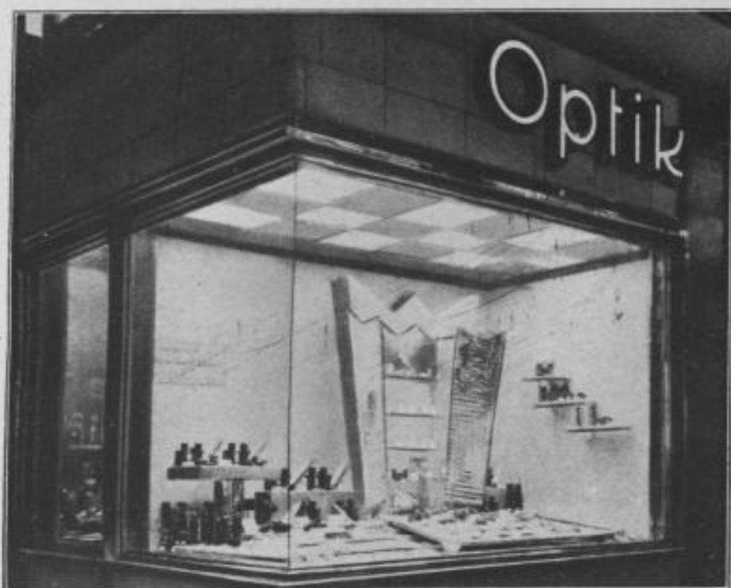
Abb. 2. Gute Beleuchtung eines Eckschaufensers durch in Kassetten eingelassene Tiefstrahler. Schaukastenbeleuchtung mit Linestra-Röhren
