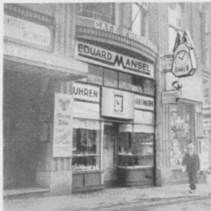
Abb. 11. Oben auf der Straßenuhr dieses Kölner Geschäftes ist der Anfangsbuchstabe des Firmennamens, ein M, zu sehen. Auch in der Form weicht diese Uhr von den üblichen Straßenuhren ab. Eine weitere Außenuhr ist über der Ladentür eingebaut. Die Worte „Elektrische Uhren“ stehen über jedem der beiden Fenster
