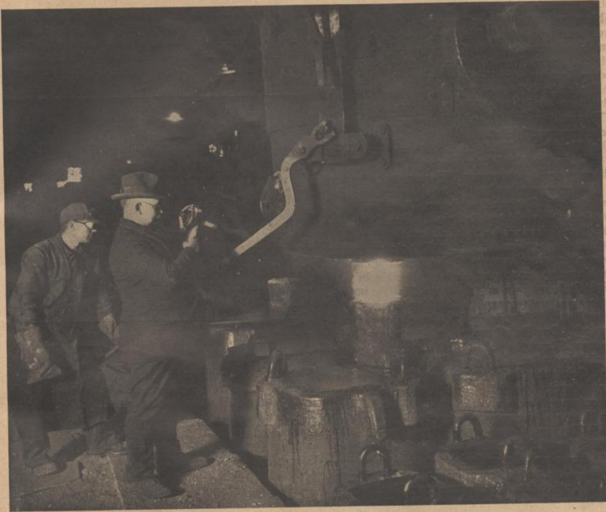
Bild 3: Messen mit dem Pyropto.
