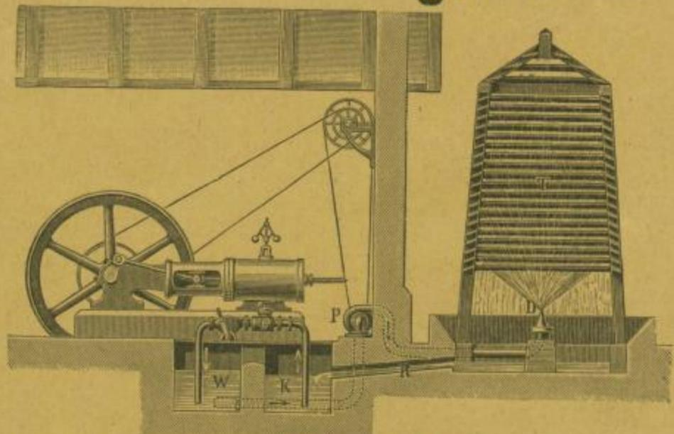
**Condensations-Anlage** mit Kühlung des gebrauchten Wassers durch
