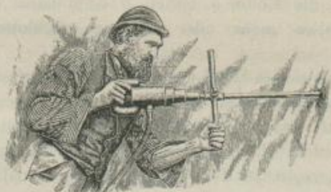
Fig. 16. Ross' Gesteinsbohrer mit Druckluft und Handbetrieb.
