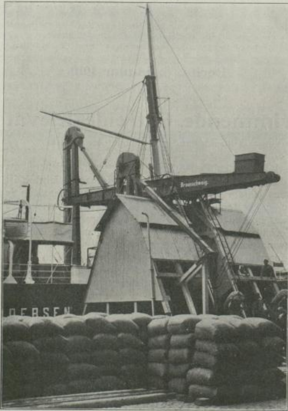
Fig. 2. Schwimmender Elevator mit Absackstation.
