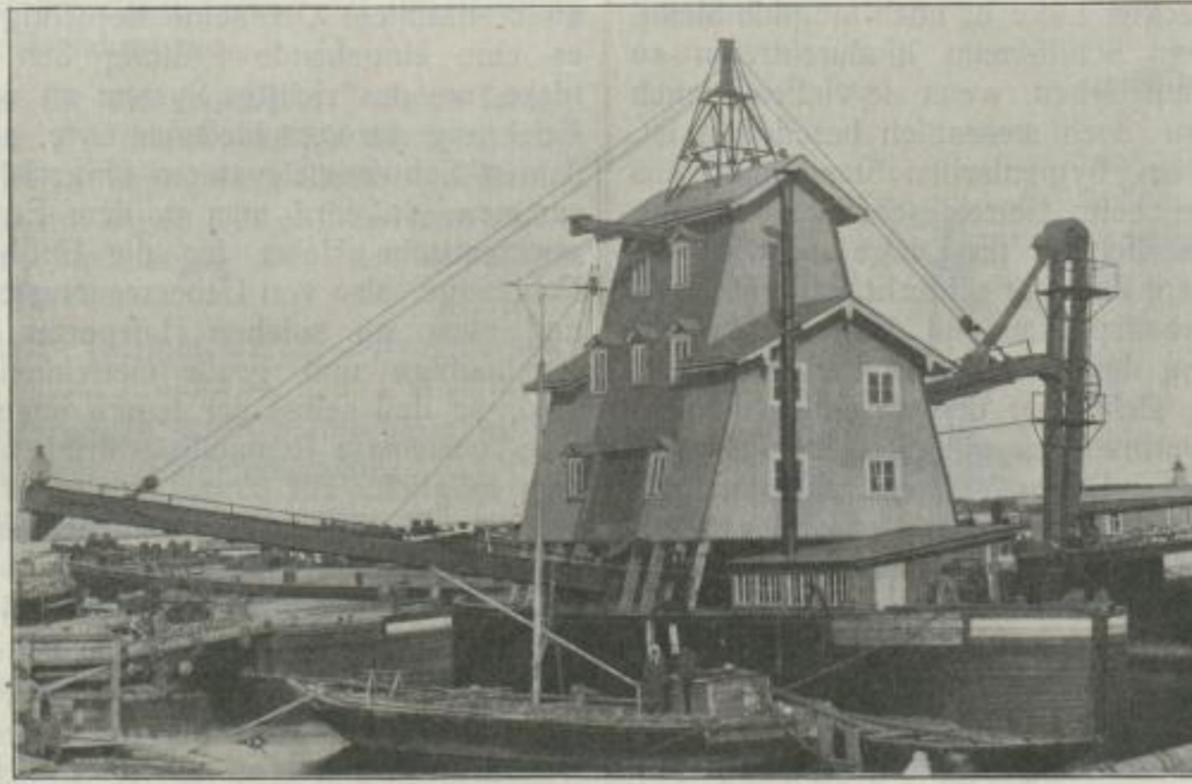
Fig. 3b. Schwimmelevator Saratow (Wolga) von Amme, Giesecke & Konegen.
