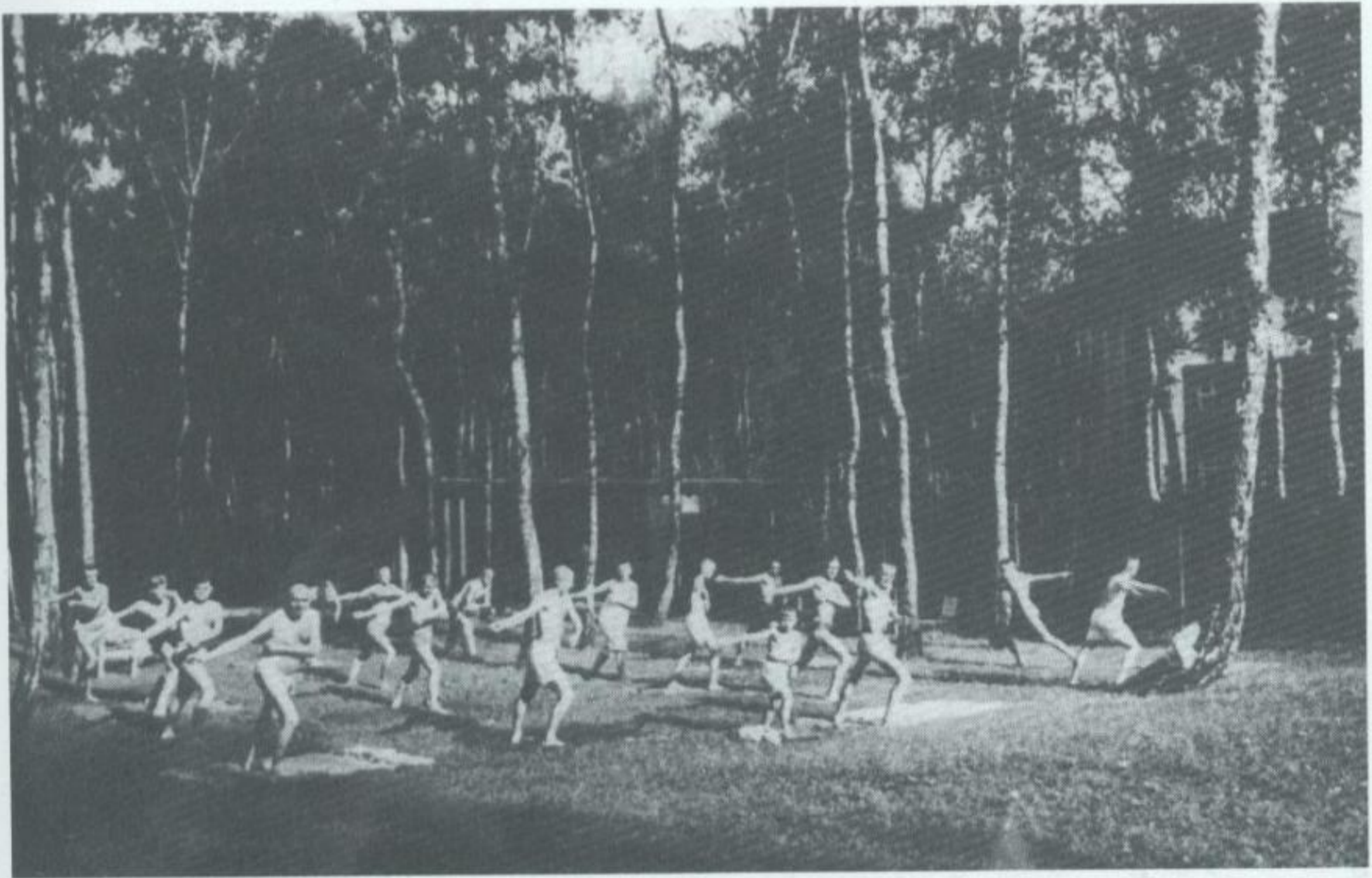
Freiluftanlage der Klinik für Naturheilkunde am Rudolf-Heß-Krankenhaus
