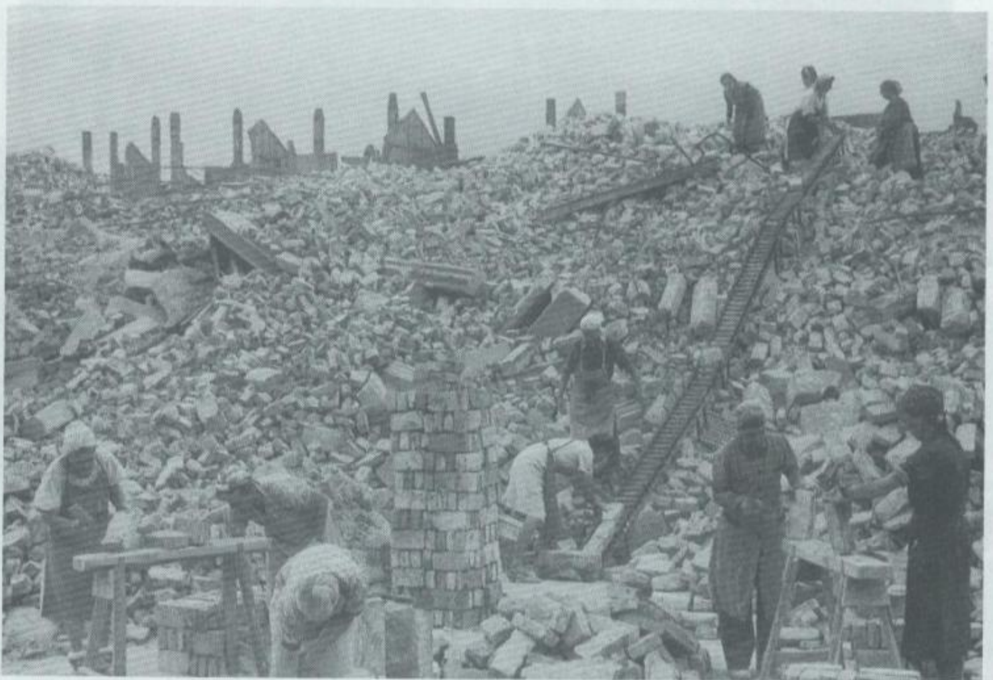
Enttrümmerungsarbeiten im Bereich Prager Straße, 1945/46, Foto Höhne/Pohl
