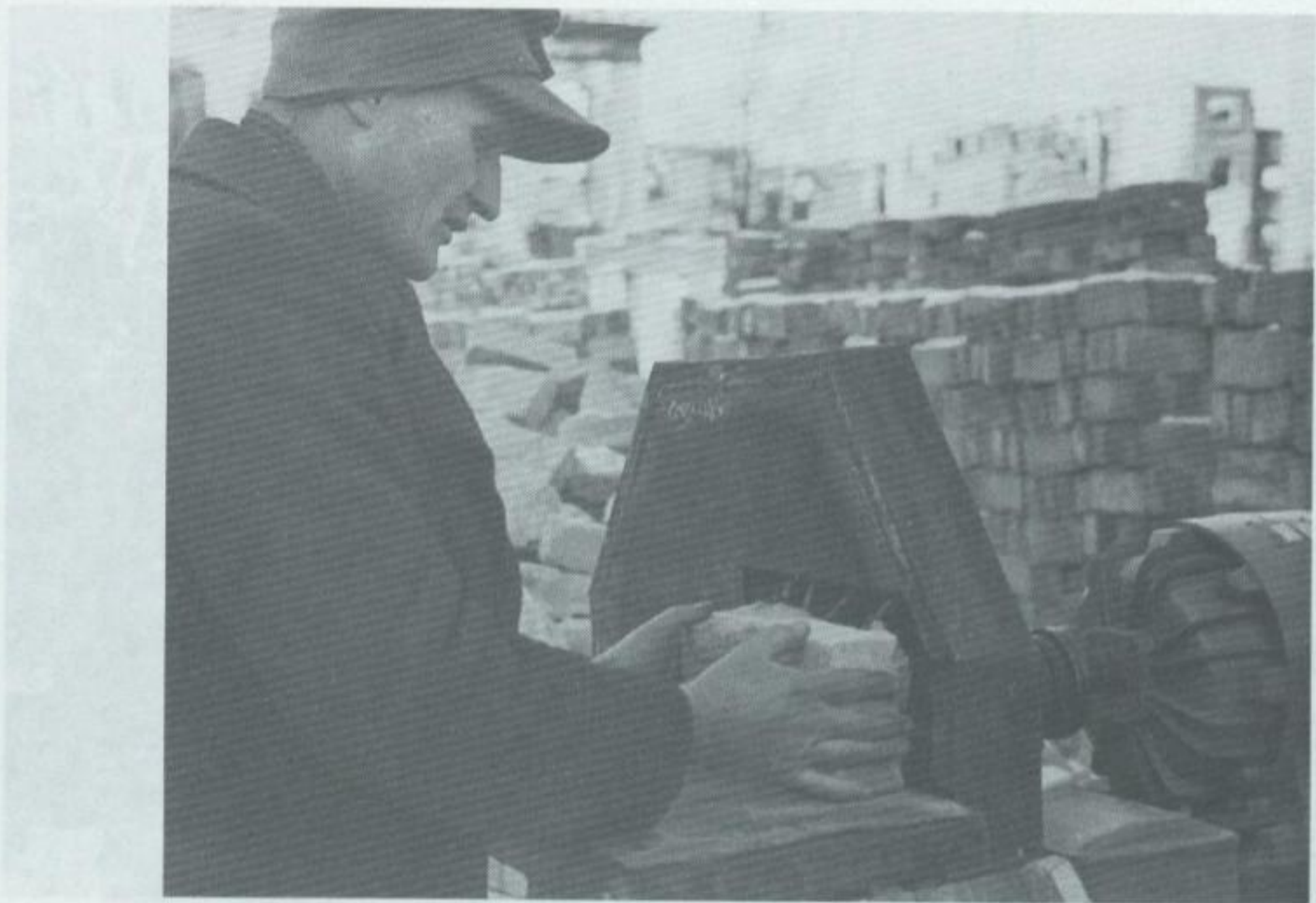
An der Ziegelputzmaschine, Herbst 1945, Foto Schaarschuch
