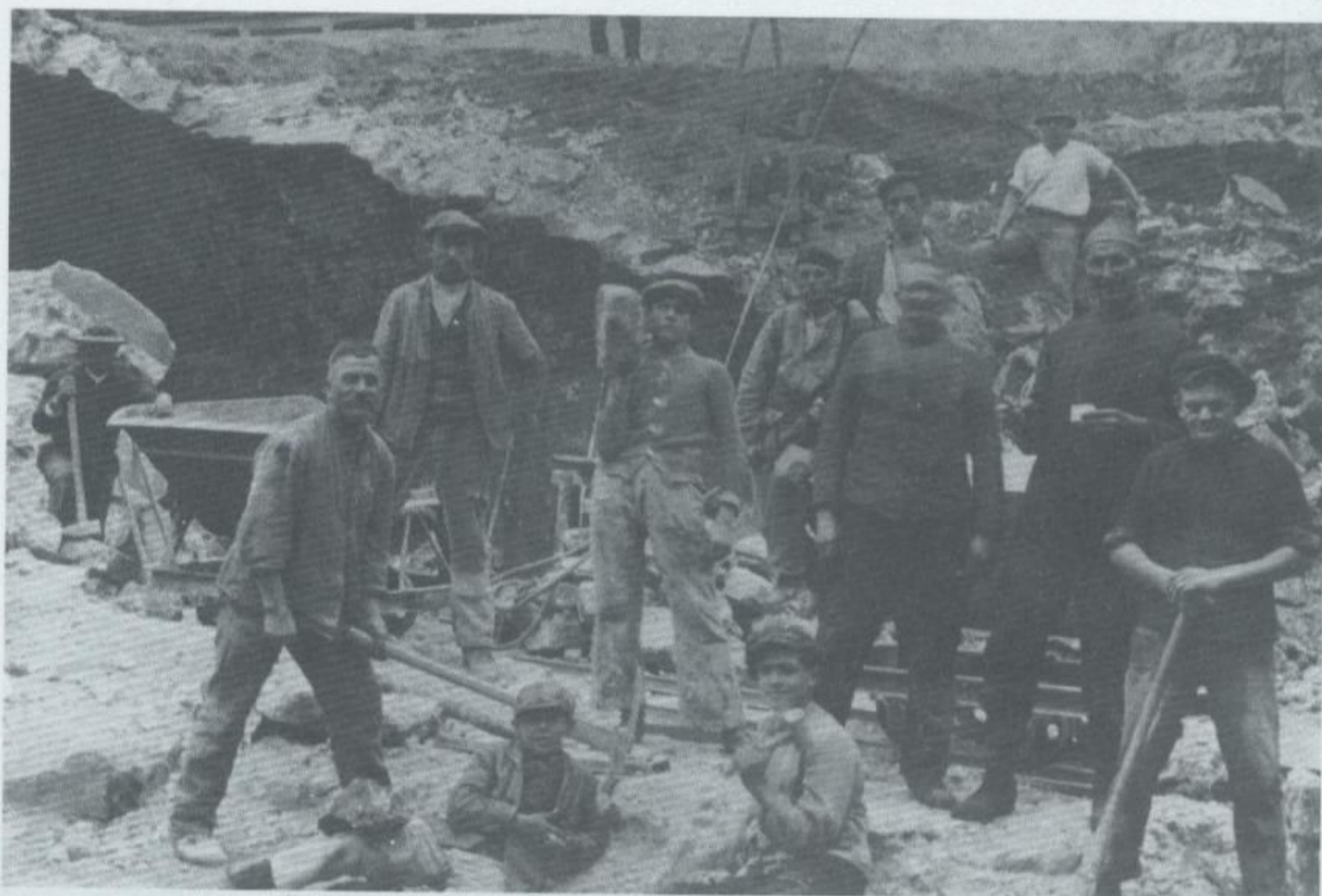
Notstandsarbeiten im September 1927, Abbruch der Kasematten, der Alten Festung Dresden
