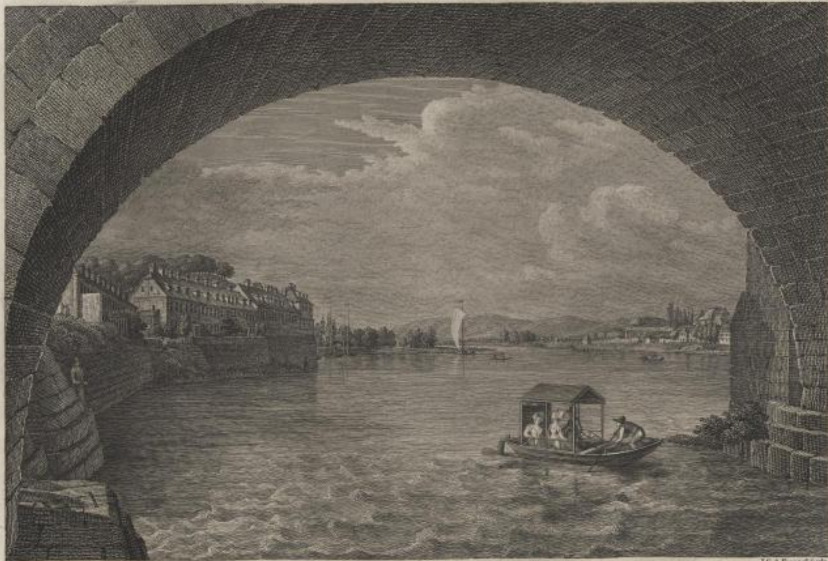
Vue occidentale du côté du Grand pont.
