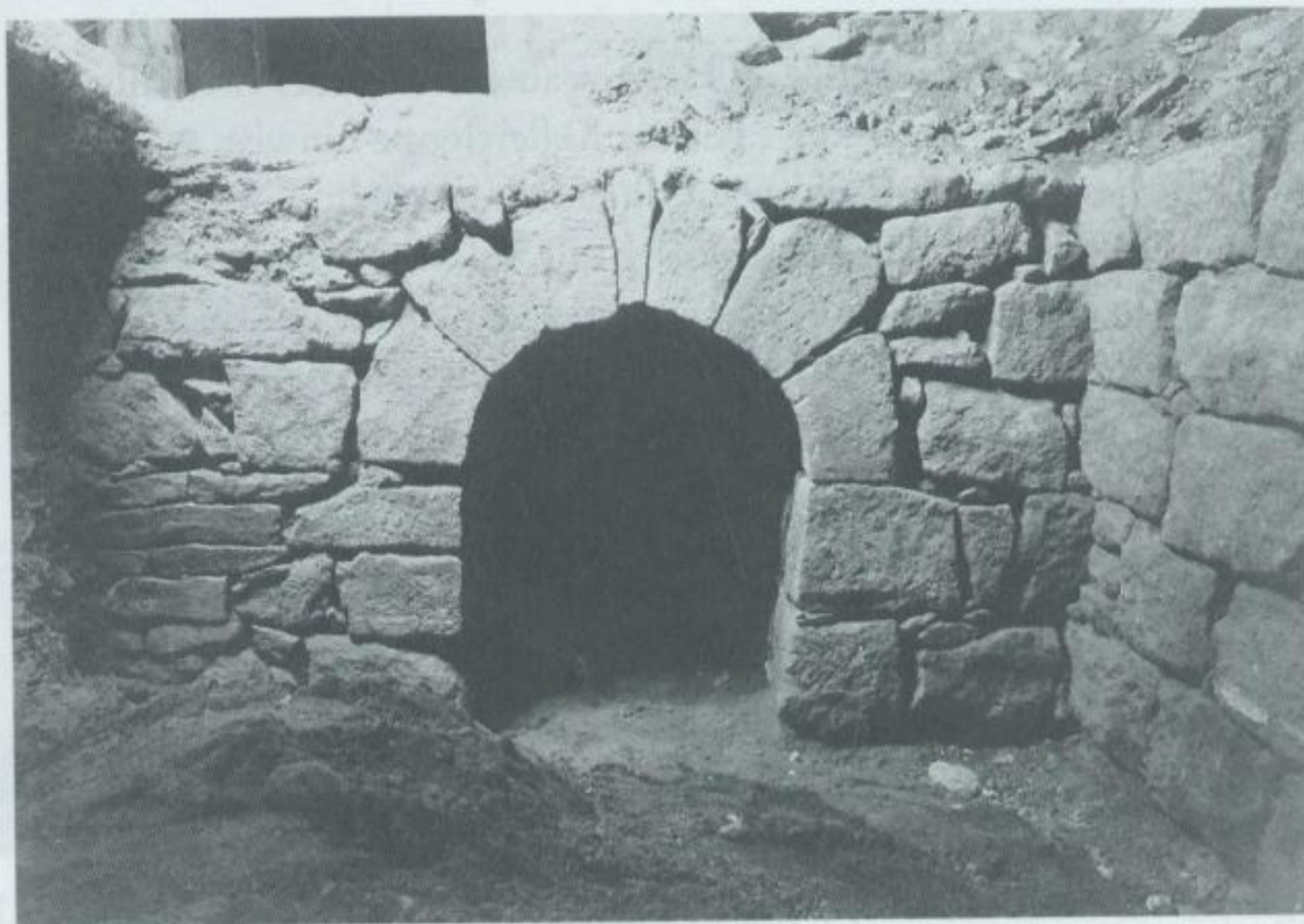
Spätromanischer Keller- raum mit fensterartiger Öffnung (Bad?) im Nord- flügel. Der Raum war ver- putzt und mit Dielung und Flachdecke versehen (Foto R. Spehr)
