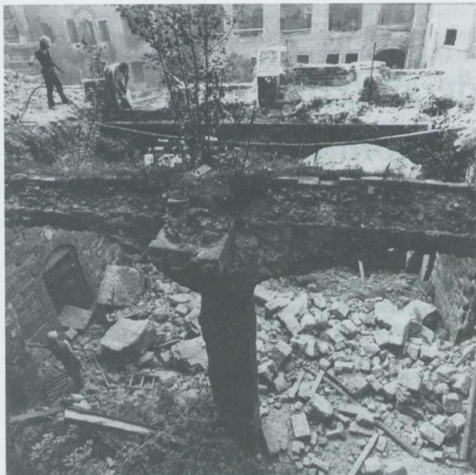
Aufräumarbeiten an der Schloßkapelle Juni 1986, Foto S. Thienel
