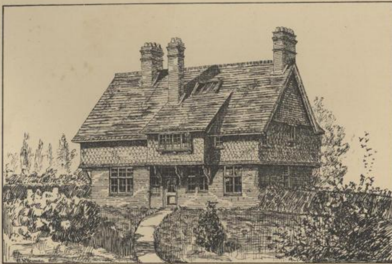
Ansicht von Nord-West.
