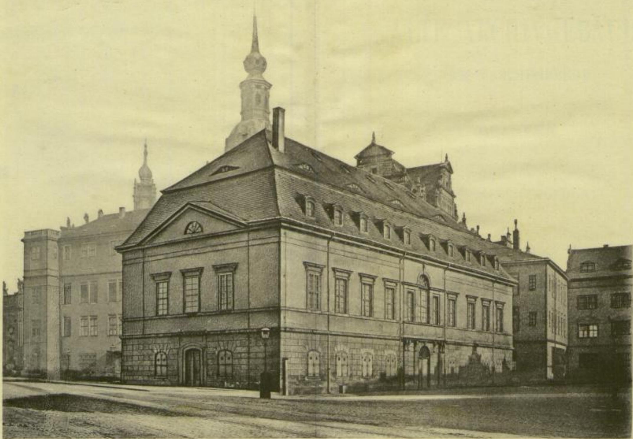
Das alte Archivgebäude vor seinem Abbruch.
