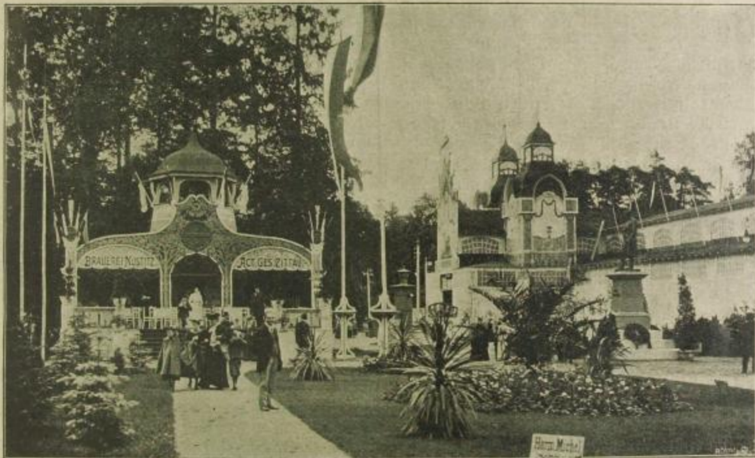
Oberlausitzer Gewerbe- und Industrie-Ausstellung: Haupthalle u. Kothalle der Brauerei Kottitz.
