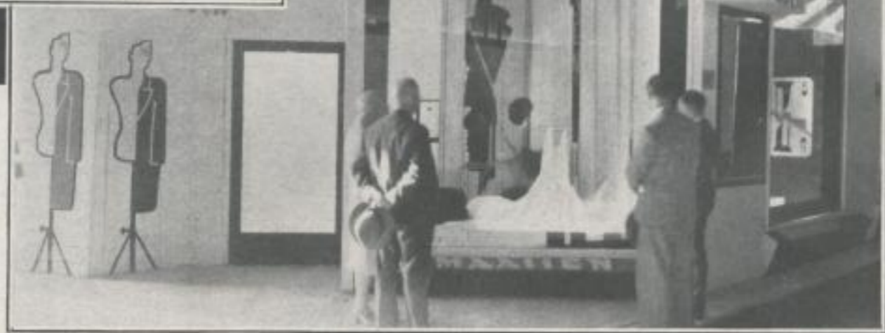
Schaufenstereinrichtung mit laufender Warenauslage
