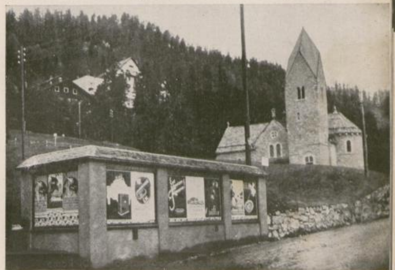
Transformatorhaus als Plakatwand, Schweiz.
