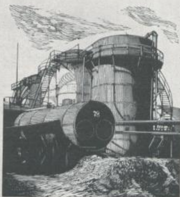
Die Kalkbrennerei in der Nähe des Vakuumschmelzwerkes, die für die Raffinerie bestimmt.
