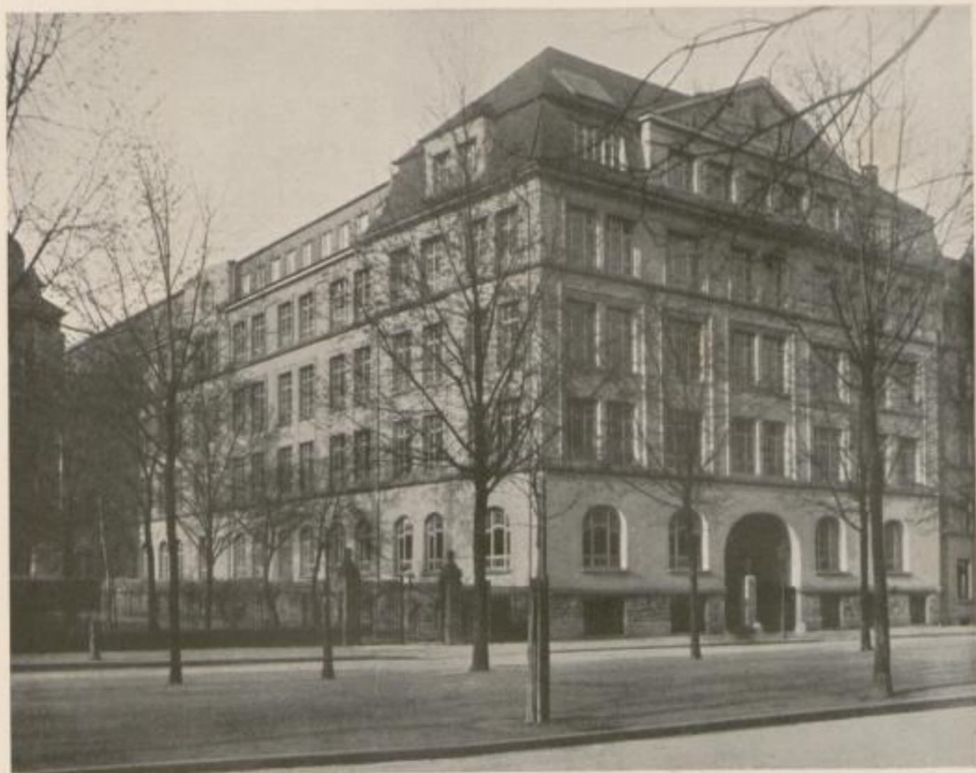
1937 Das jetzige Betriebsgebäude der Bauerschen Gießerei Frankfurt a. M. Moltkeallee 45
