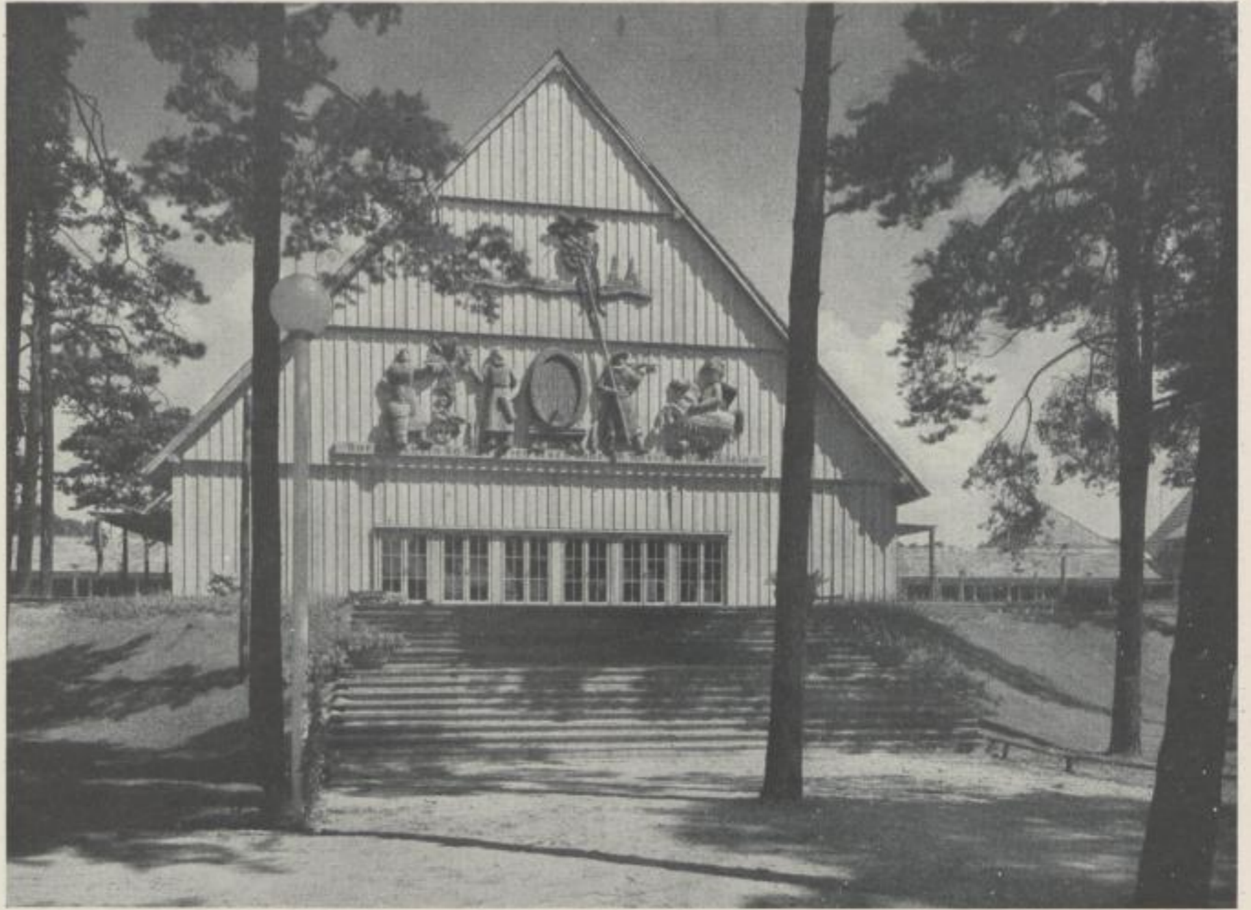
Giebelseite der KdF-Rheinlandhalle Architekt Prof. Schulte-Frohlinde
