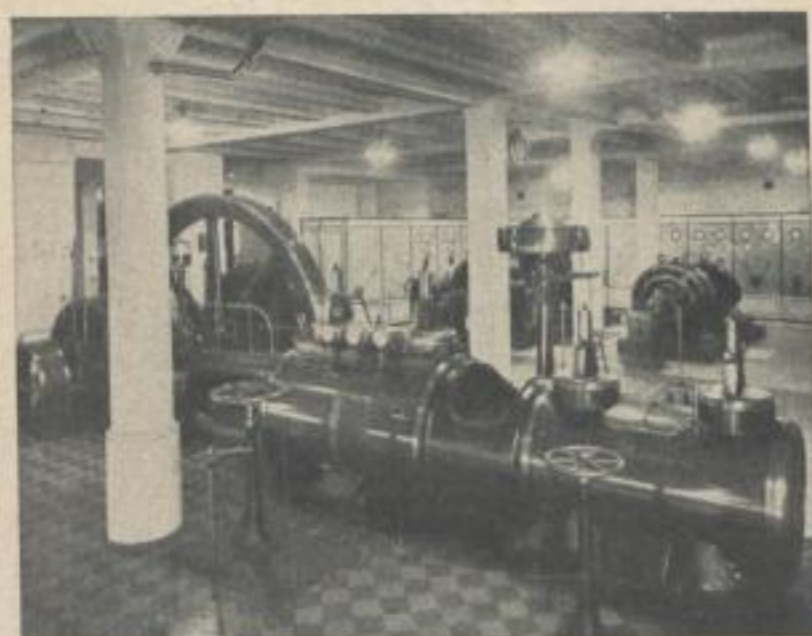
300 PS Dampflokomobile in der Kraftzentrale des Verlagsgebäudes
