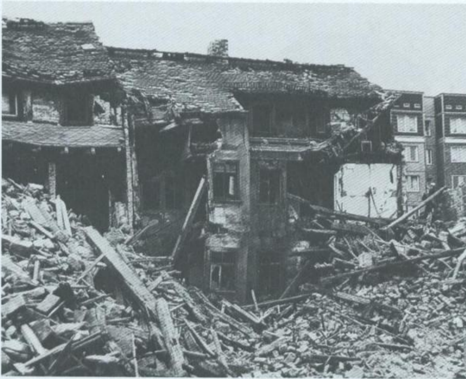
Abrißhäuser in der Schäferstraße (Nr. 16 bis 20)
