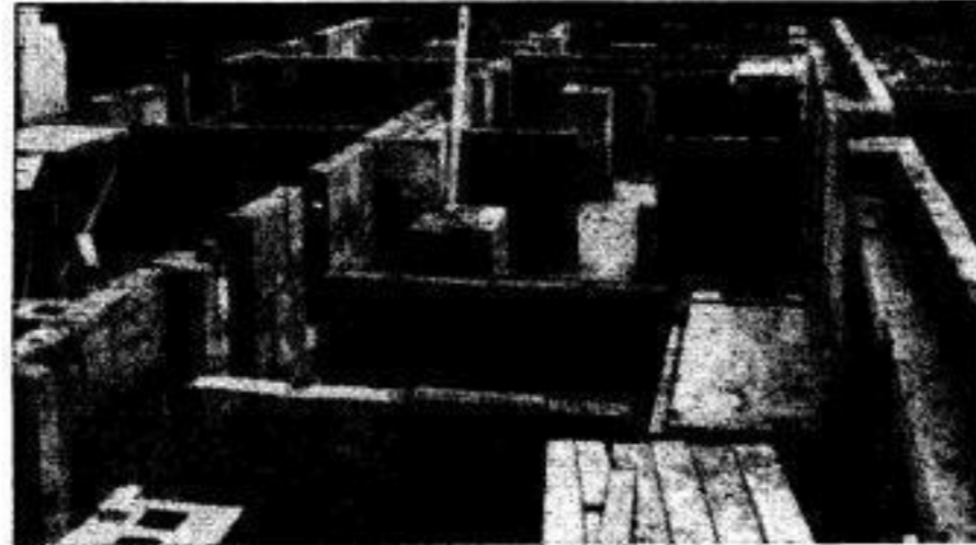
Blick auf eine Großblockbaustelle in Dresden-Striesen
