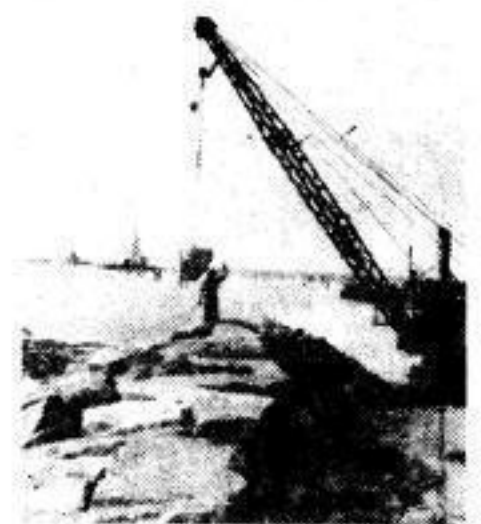
Foto: Zentralbild „Schwere Brocken“ werden zum Bau der Hafenanlage benötigt
