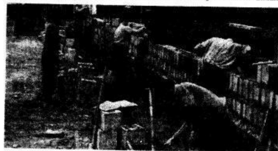
Eine Baubrigade der Seminargruppe (vgl. unser Titelbild) beim Bau eines Schweineoffenstalles.
