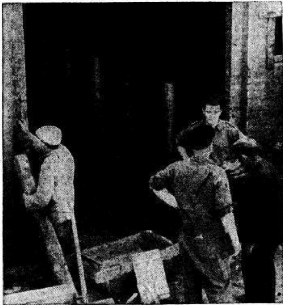
Erfahrungsaustausch zwischen der 1. LPG-Brigade und den angehenden Bauingenieuren beim Bau des Kälberaufzuchtstalles in Strauch (Kreis Großenhain).
