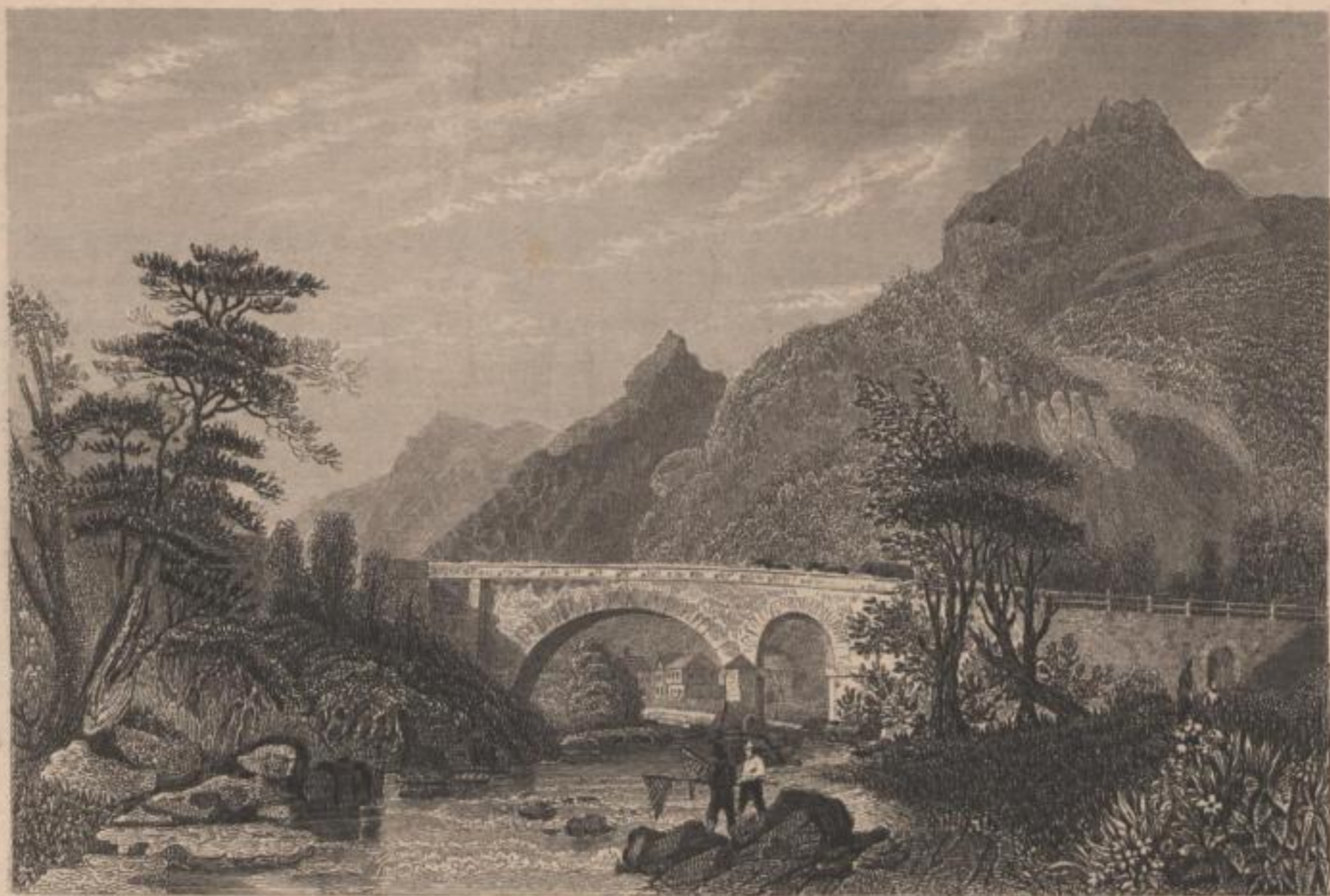
BRÜCKE AUF DER ST. GOTTHARDS STRASSE
