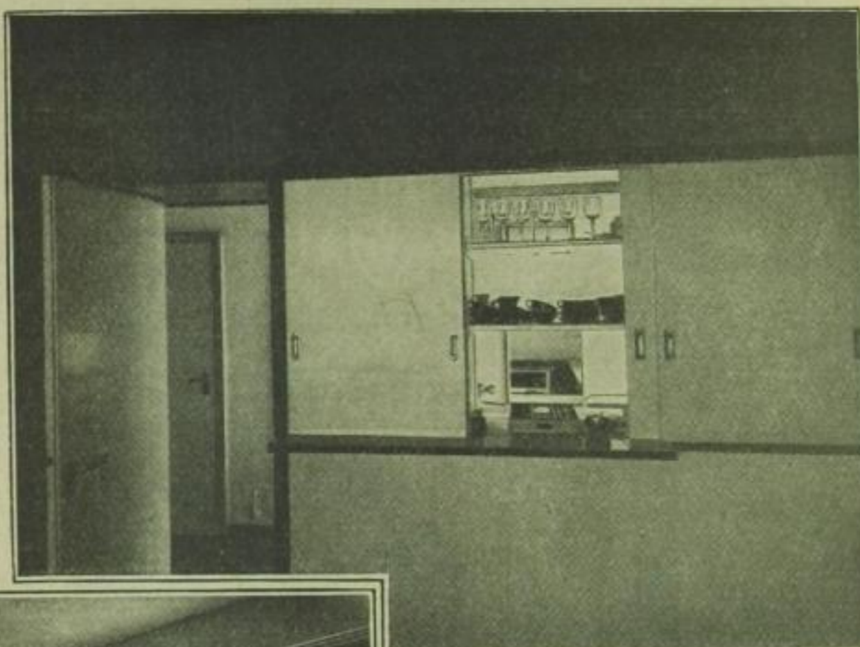
Wandschrank im EBzimmer mit Durchblick nach Anrichte und Küche
