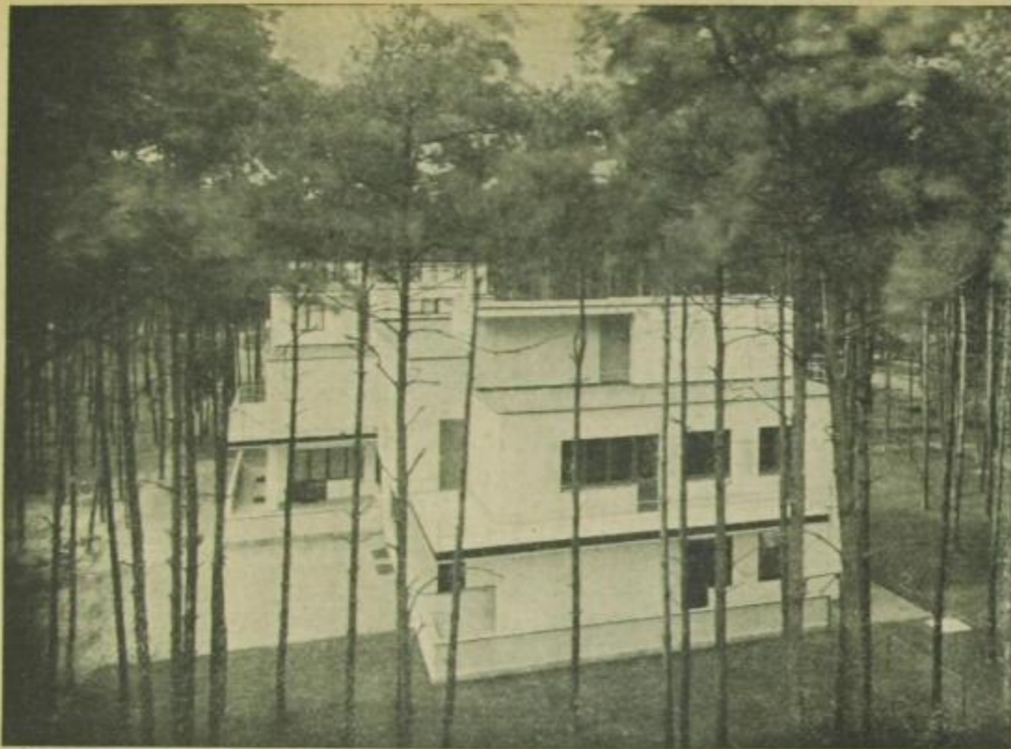
Doppelwohnhaus für zwei Familien in Dessau. Die eine Haushälfte enthält die Wohnung des Professors Moholy-Nagy. Architekt: Prof. Gropius.
