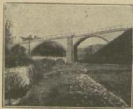
Dreigelenkbogenbrücken des Viaduktes Bahnlinie Weißig-Dürröhrsdorf.
