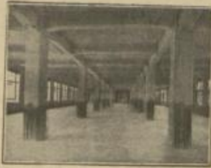
Eisenbetondecken u. -Säulen 14 000 qm GEHE & Co. A.-G., Dresden.
