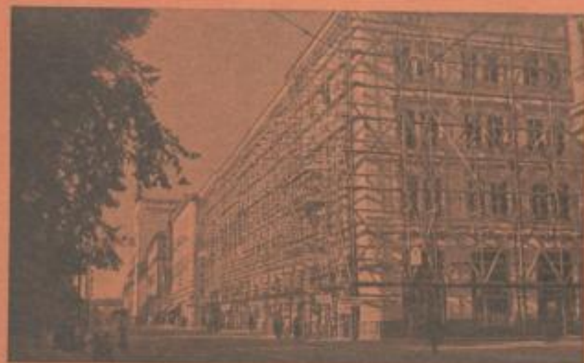
Gerüst an der Georgenhalle (Sitz der Direktion der Stadtwerke zu Leipzig)
