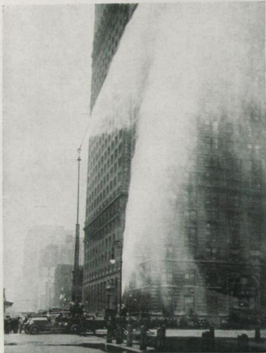
New Yorker Wasserturm, der Wassermengen bis zum dreißigsten Stockwerk emporschleudert
