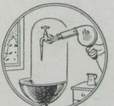
16. Auftauen der Wasserleitung
