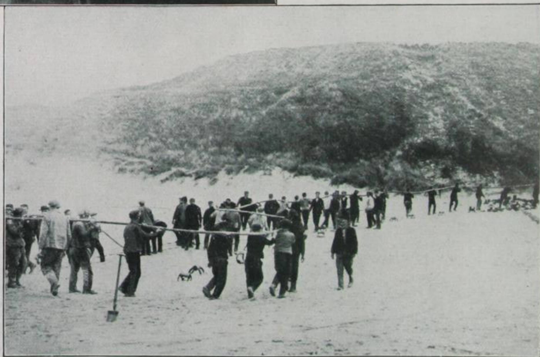
Landung des Kabels in der holländischen Station Domburg.
