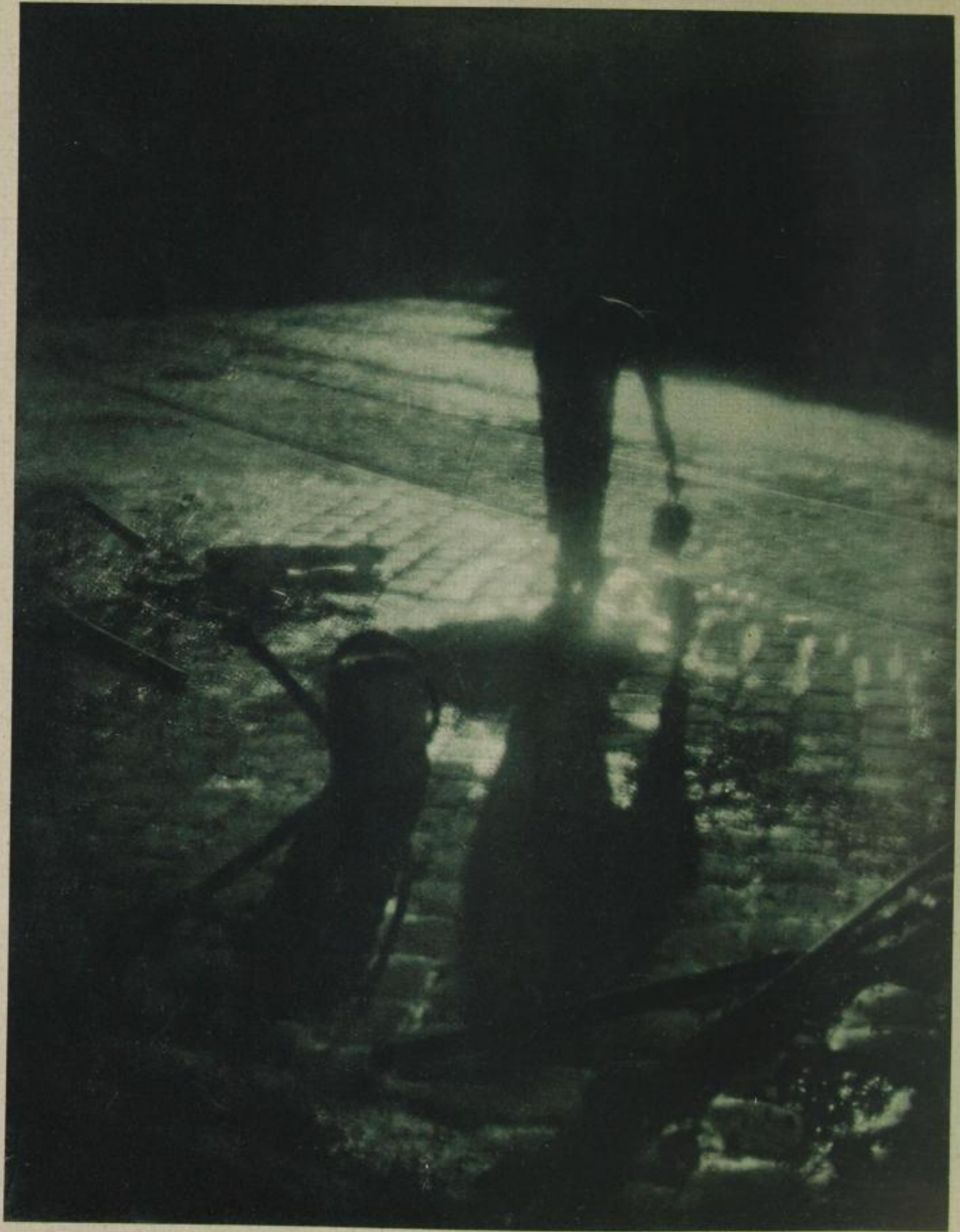
Nächtliche Asphaltarbeit Aufnahme von Christian Voigt
