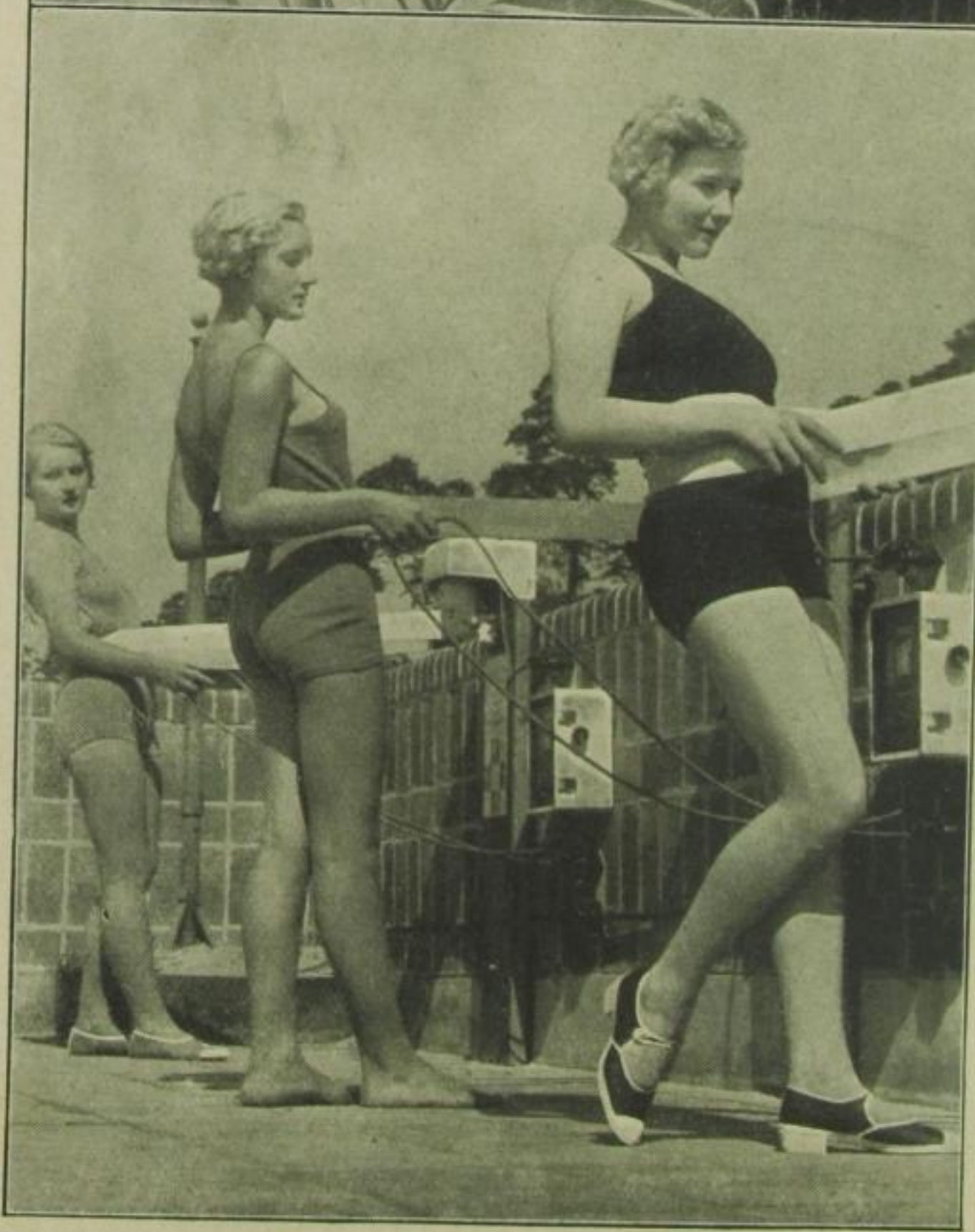
Auf dem Dach des Wannseebades
