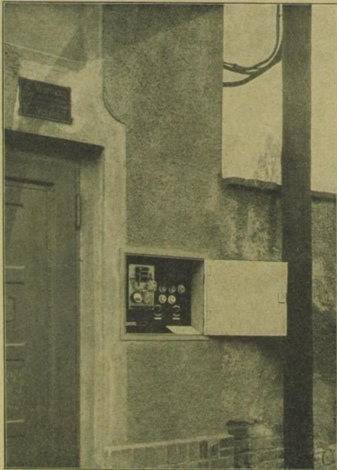
Vorrichtung zur Einschaltung der Nachtbeleuchtung einer Stadt
