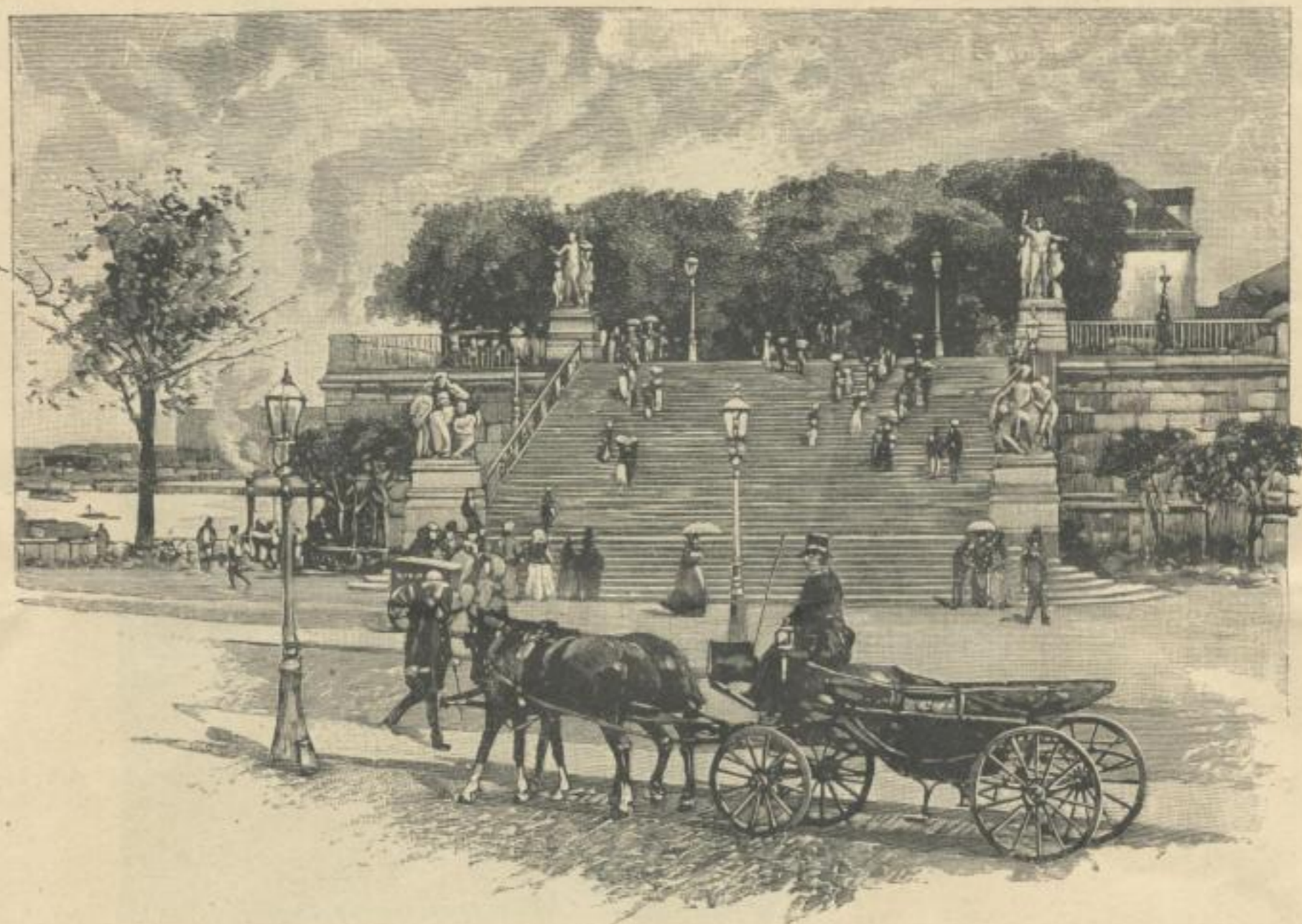
L'ESCALIER DE LA TERRASSE DE BRÜHL
