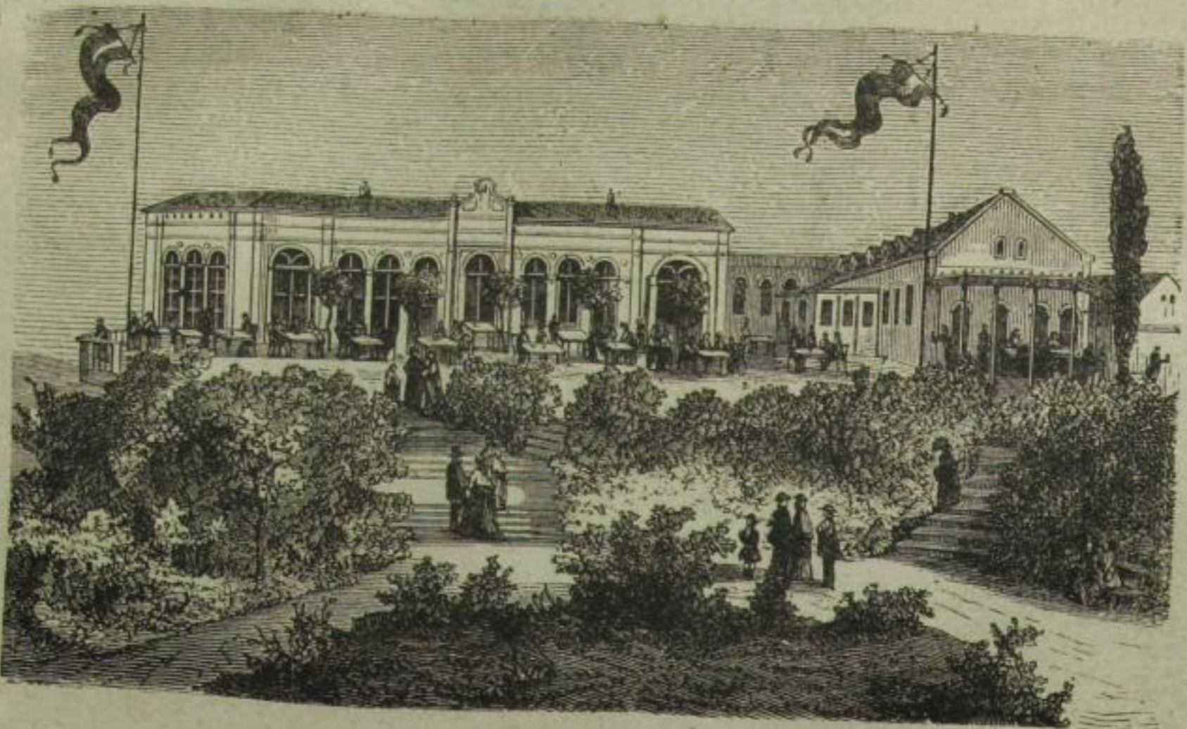
Restauration zum Bergkeller.
