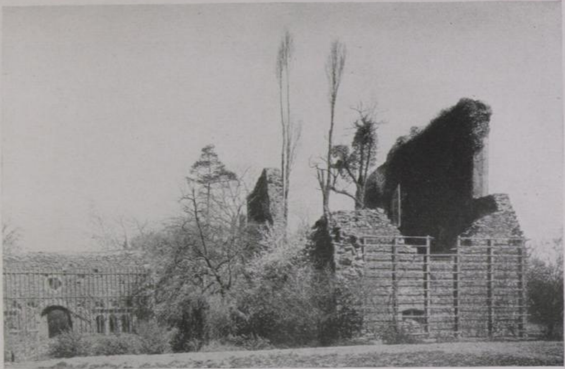
Abb. 6. Altes Bild derselben Ecke vor der Freilegung und Beseitigung der Terrassen (bei 7 und 8 nach 9 ansteigend; vgl. Abb. 4). (Phot. unbekannt)
