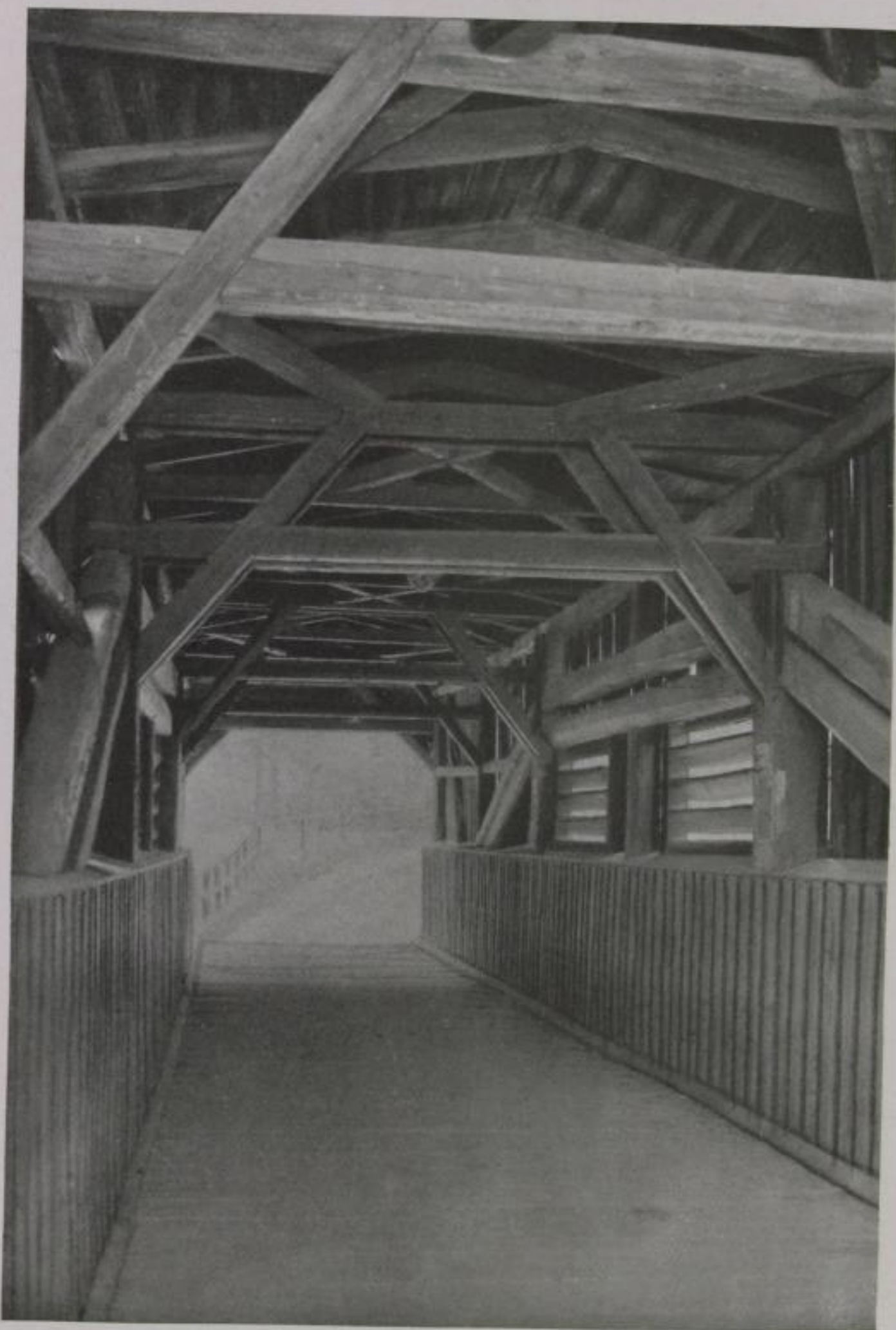
Abb. 5. Noßwitz bei Elsterberg i. D. Inneres Rechts ist das Hängewerk der einjochigen Brücke gut sichtbar
