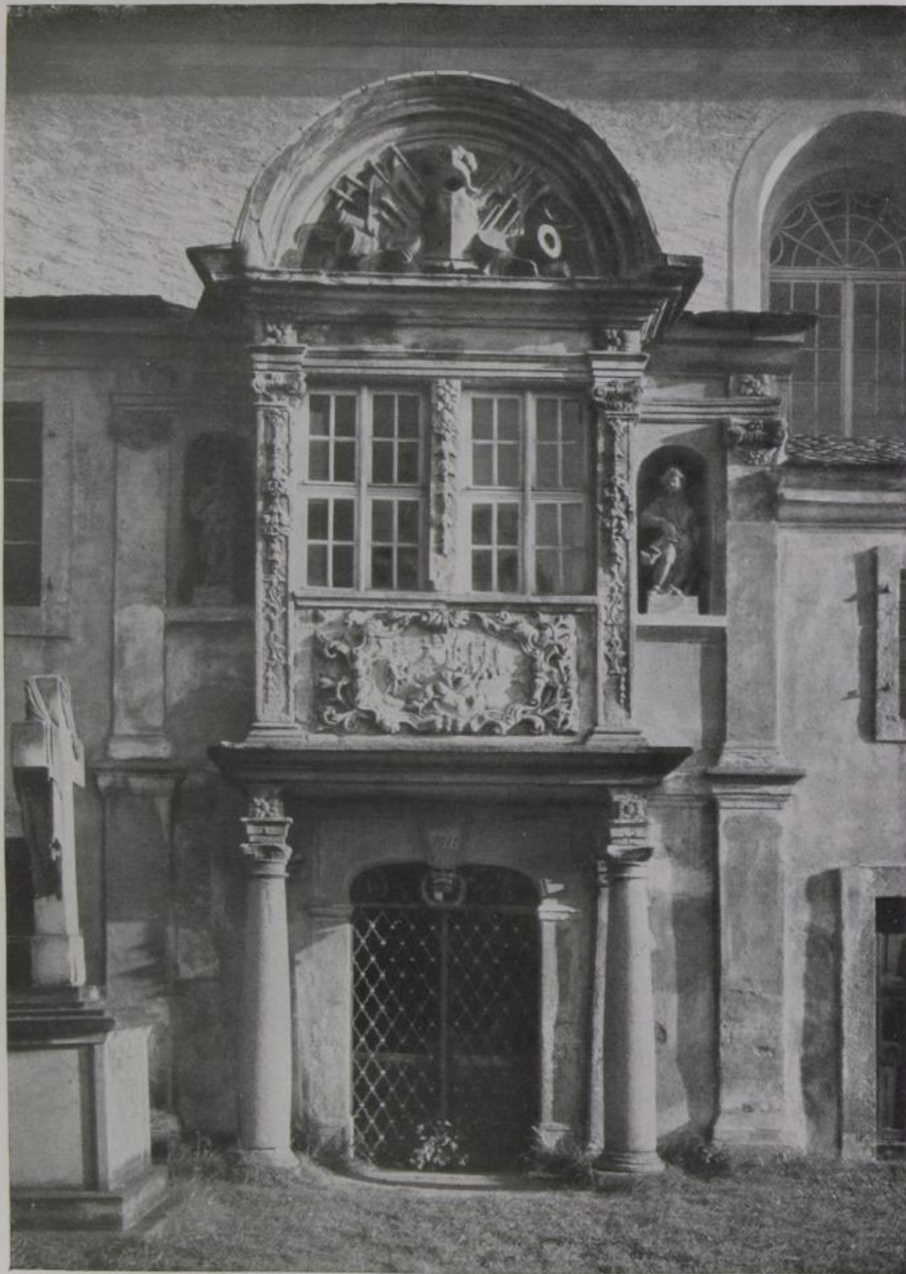
Abb. 13. Auf dem Friedhof. Die Lehnsche Grust an der Südseite der Kirche in Hochkirch
