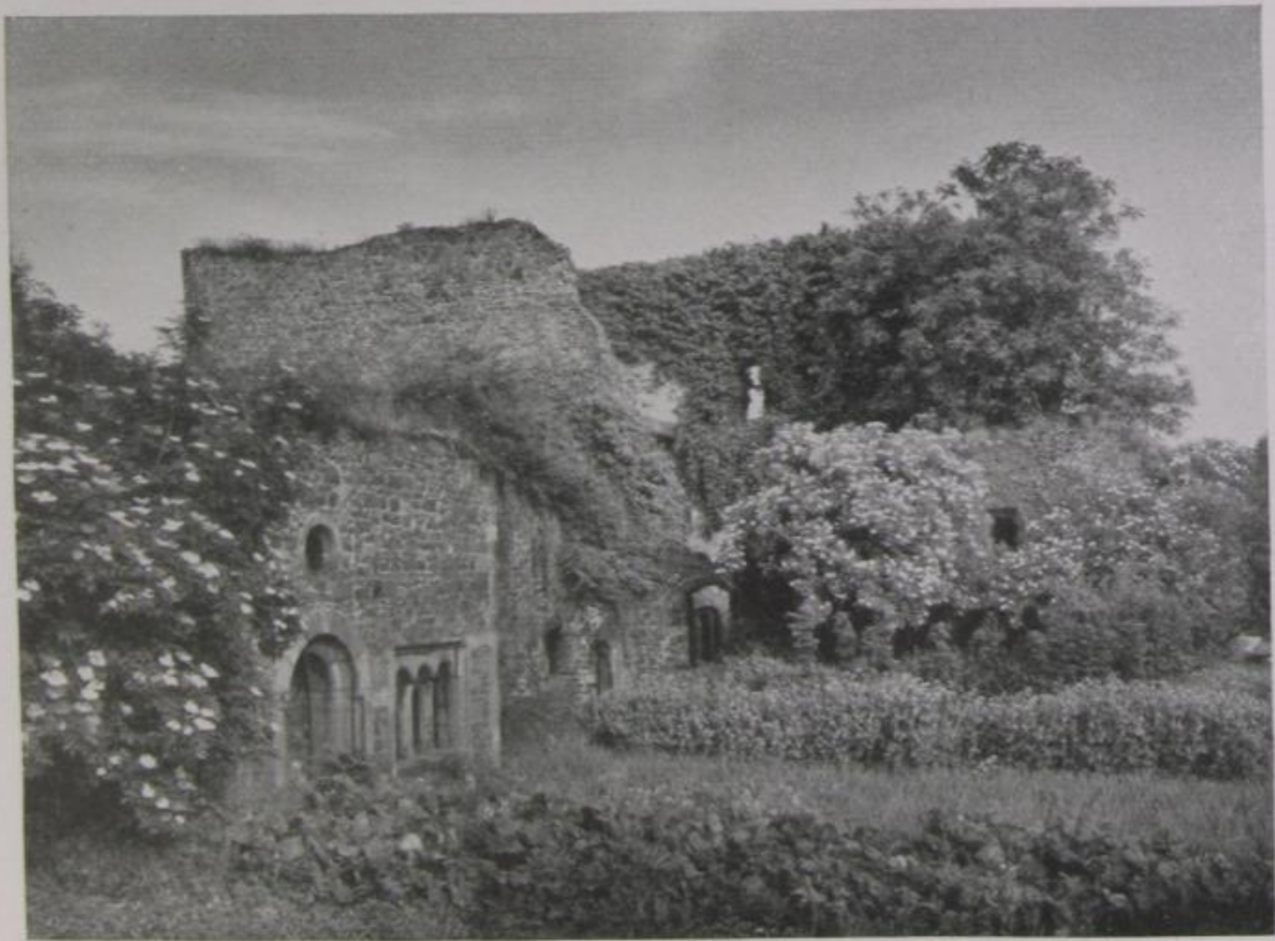
Abb. 7. Derselbe Teil mit Kapelleneingang und Treppenrücklage (5b—7: alter Zustand)
