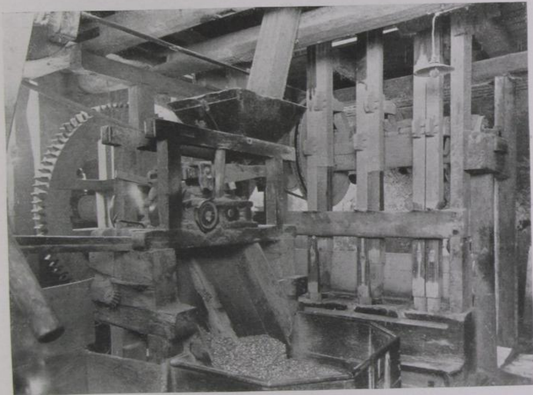
Abb. 11. Mahlkammer (Stampfwerk) der Weichelmühle
