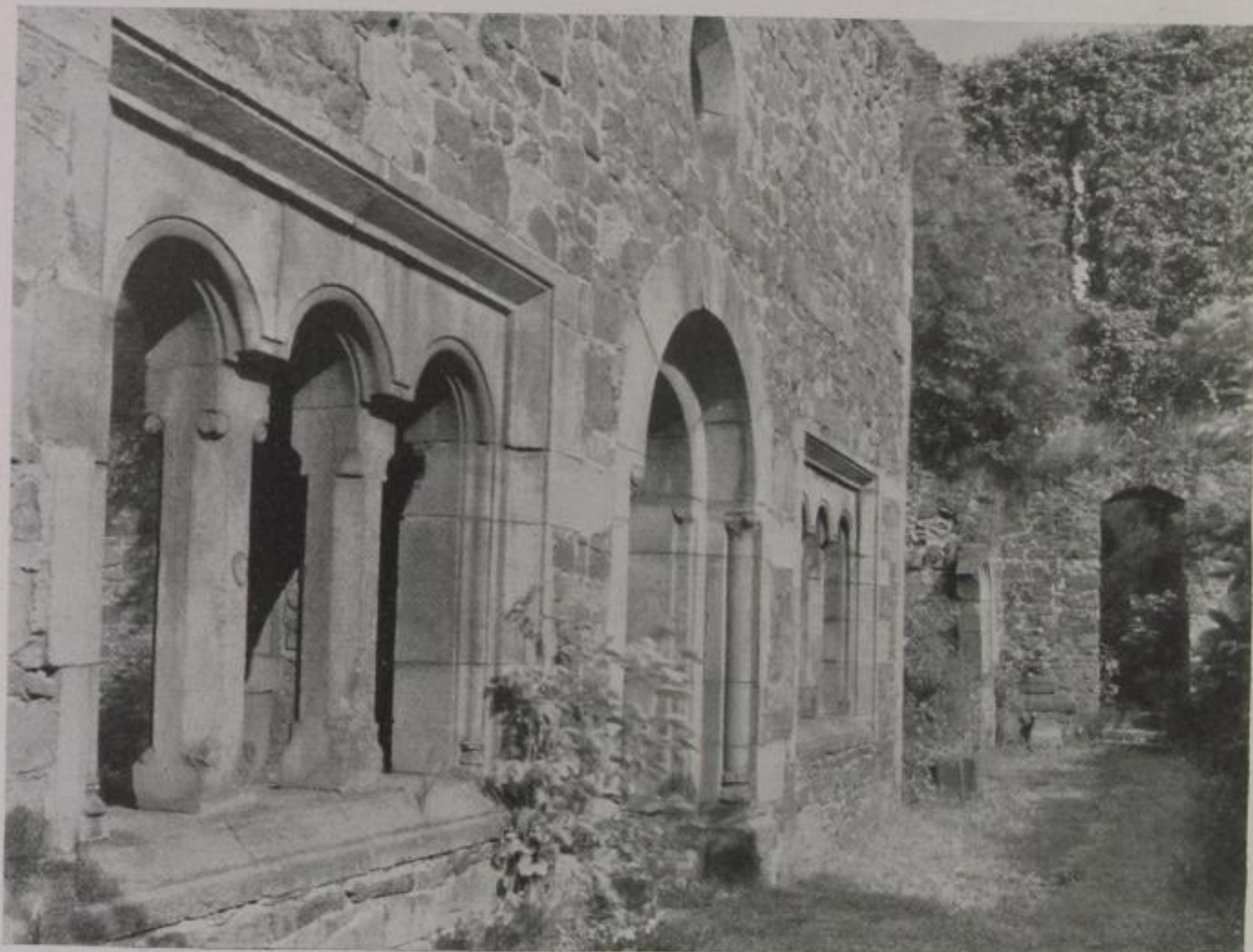
Abb. 10. Derselbe Teil mit Blick auf den Nordkapelleneingang am Ende des zu ergänzenden Kreuzgangs. In der Rücklage das unter der Treppe zum Schlafhaus in Resten erhaltene Tor d. Sakristei od. Marienkapelle. Man beachte d. verschiedenartige Abkantung d. Fensterpfeiler nationalgermanische Baustoff beim Bauernhaus und auch später beim Stadthaus war.
