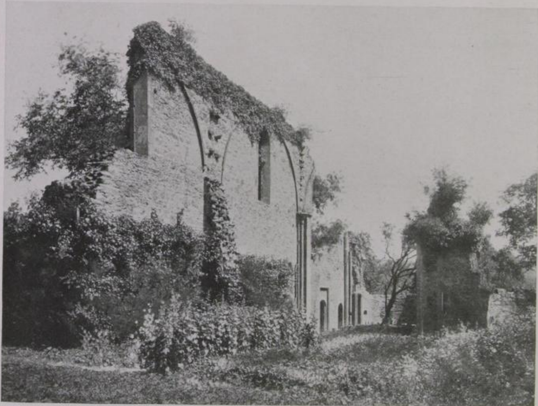
Abb. 23. Dasselbe näher betrachtet, mit Choreinblick. Rechts die südliche Nebenapsis (Nach der Freilegung und Abbruch der Lettnerwand (1914))
