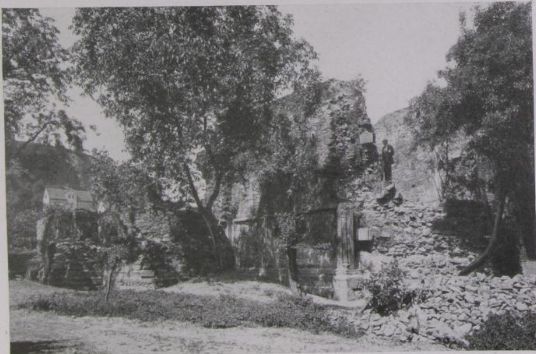
Abb. 25. Außenansicht des Chors (mit Hauptapsis) und der südlichen Nebenapsis (links) Erstere mit gesäultem Eckpfeiler. Darüber ein Eckstein des Chorvierecks
