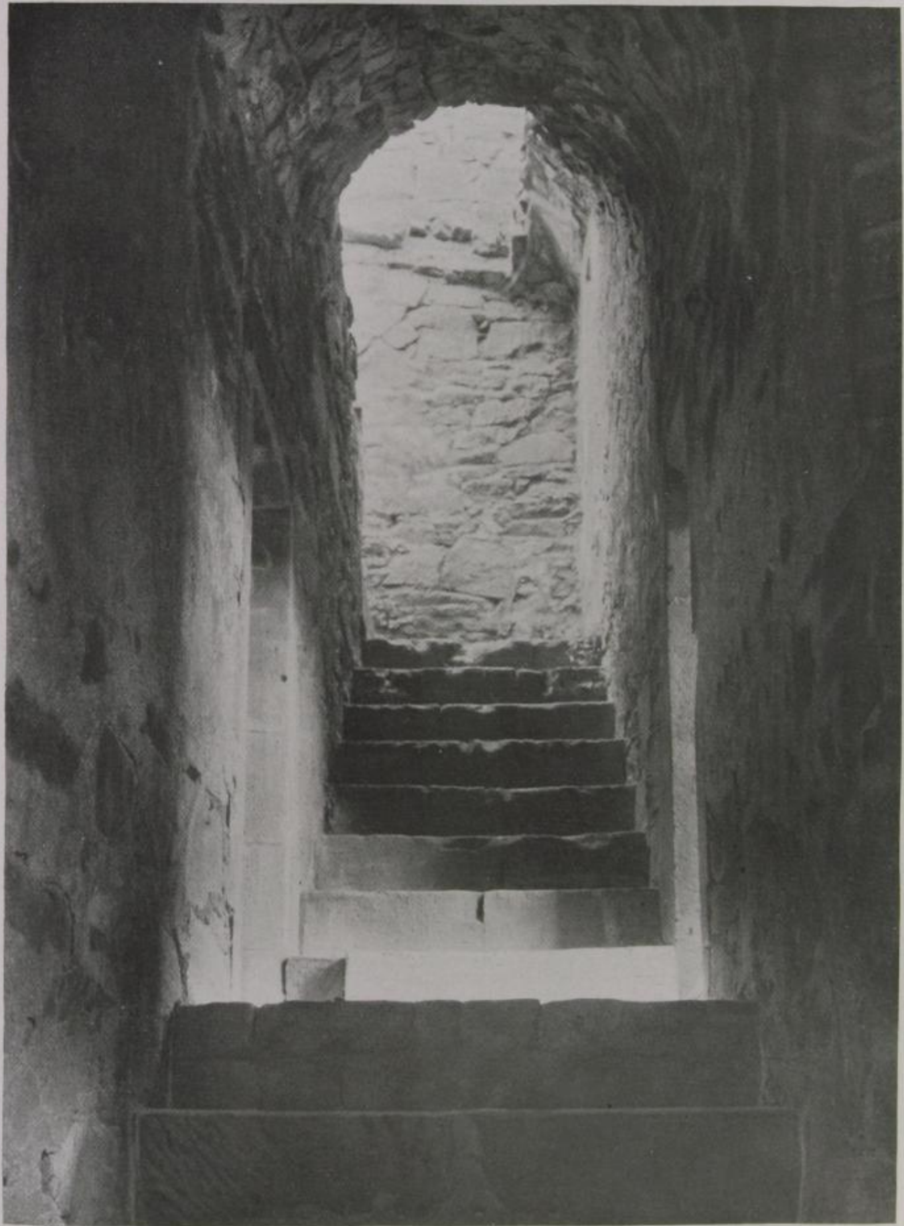
Abb. 19. Stiege vom Kirchenchor zum Schlafhaus Links das die Schachtkammer mittelbar erleuchtende Fenster
