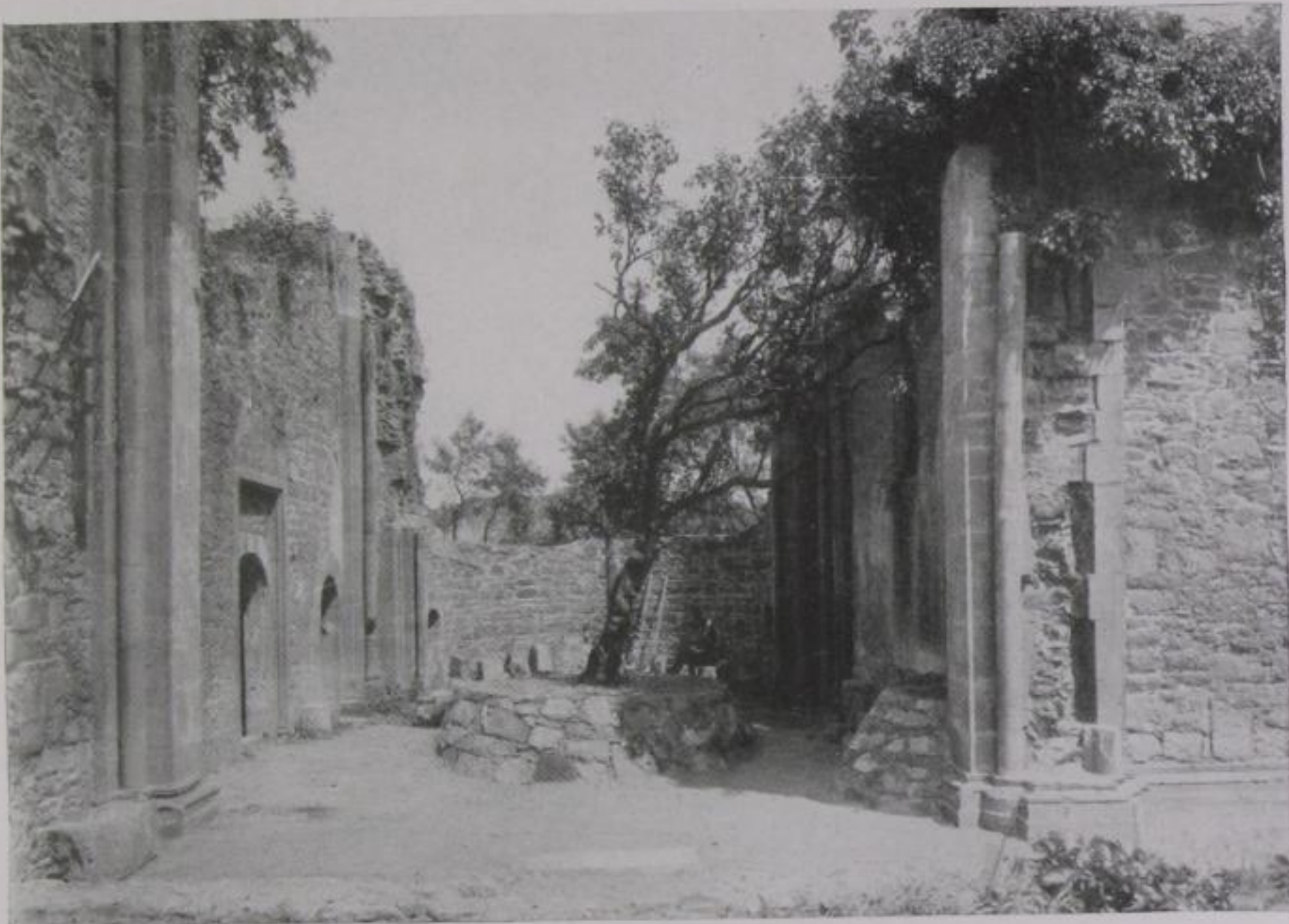
Abb. 24. Blick in den Chor der Kirche. Nach der Freilegung (1914) und Beseitigung des Schutts Im Vordergrund die Triumphbogenpfeiler, zwischen denen die Lettnerwand eingezogen war. Die Schatzkammertür mit rechteckiger Umrahmung nach Art der Kluniazenser (Hirsauer)
