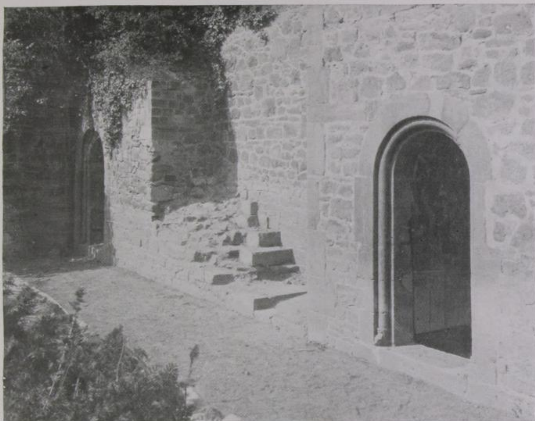
Abb. 14. Refektoriumstür mit Treppenrücklage und (links) Küchentor. Ersteres Tor ähnlich dem der Martinskirche in Meißen. Die Ecke über der Treppe ist falsch ausgebessert
