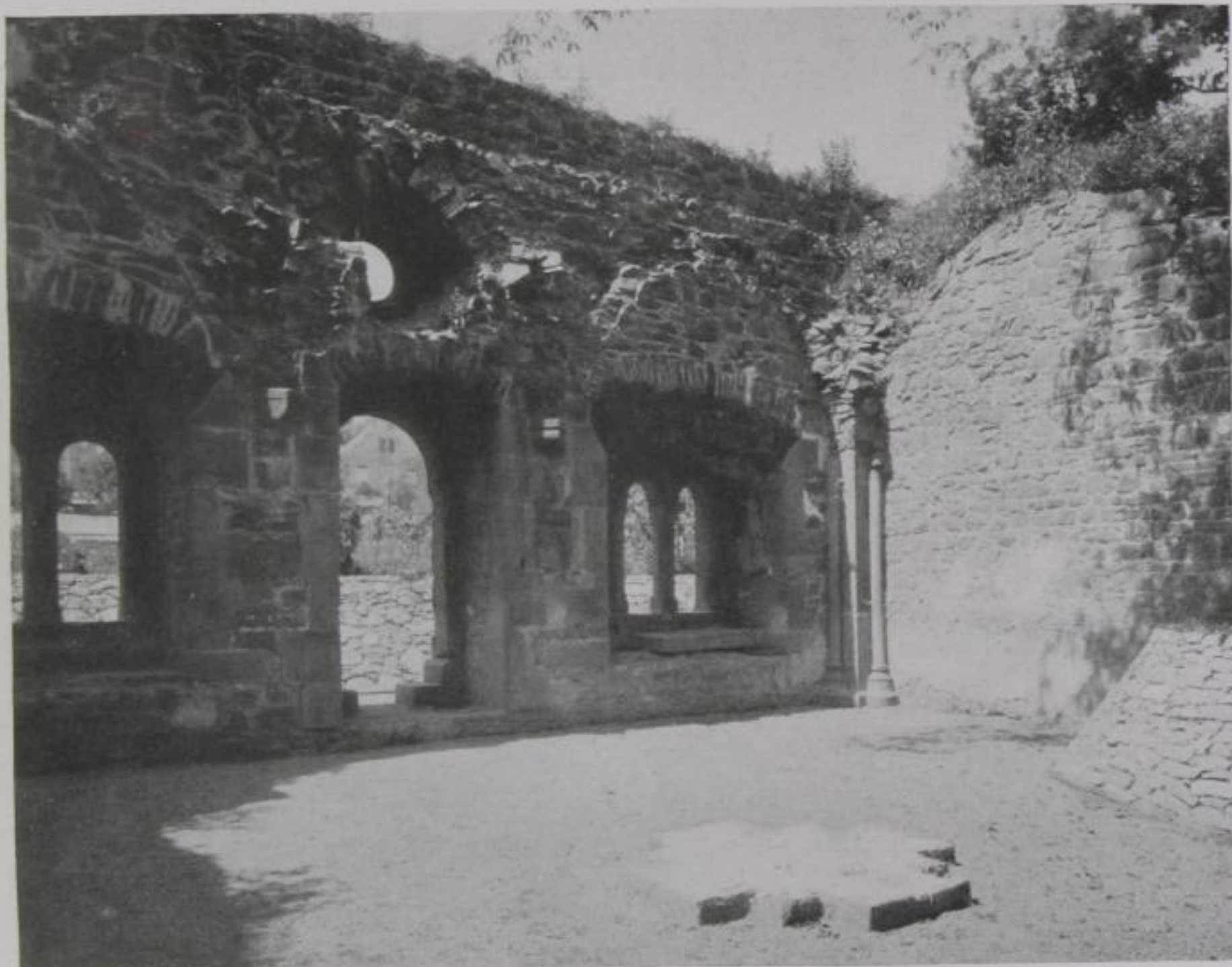
Abb. 12. Kapitelsaal, Inneres, mit freigelegtem Mittelpfeilerrest, seitlich der Tür die Kragsteine für das Zwischengewölbejoch
