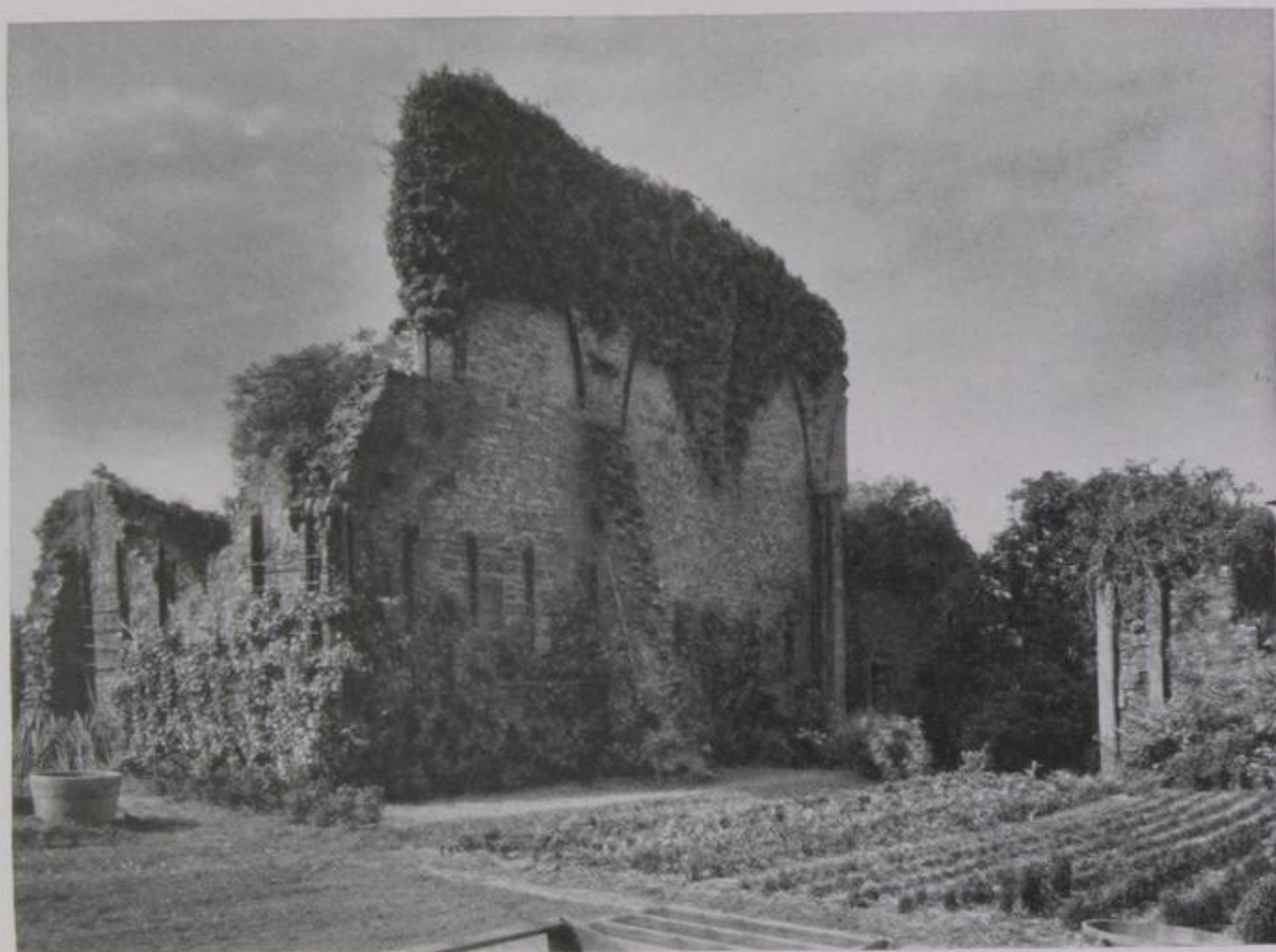
Abb. 22. Blick ins Dierungs- und Ostjoch der Klosterkirche, mit der hohen Nordwand. Vor dem einen Wandpfeiler ein zur Sicherung der ausbiegenden Mauer vorgesehter Stützpfiler aus der Mitte des 19. Jahrhunderts. Die Lettnerwand ist schon beseitigt.
