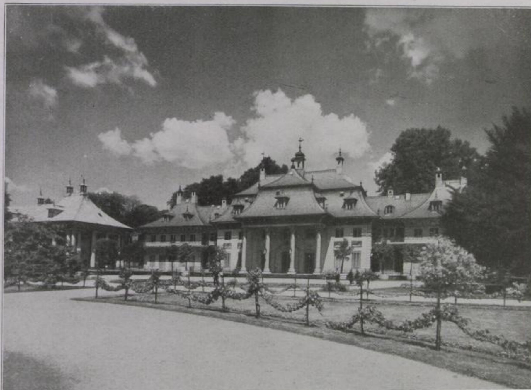
Abb. 8. Pillnitz, Bergpalais, Ansicht von der Gartenseite
