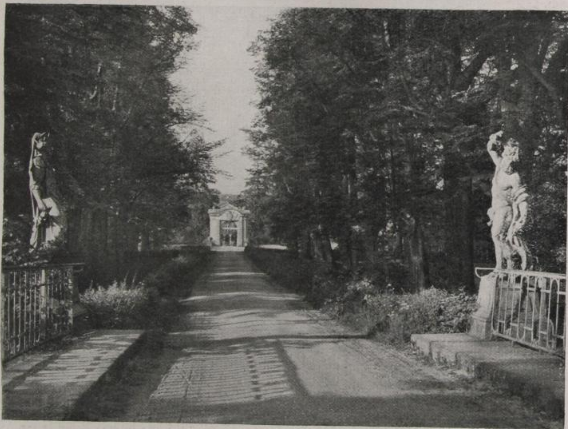
Abb. 2. Zufahrtsstraße von der Wittigbrücke, im Volksmunde „Männelbrücke“ genannt, aus gesehen mit mythischen Figuren
