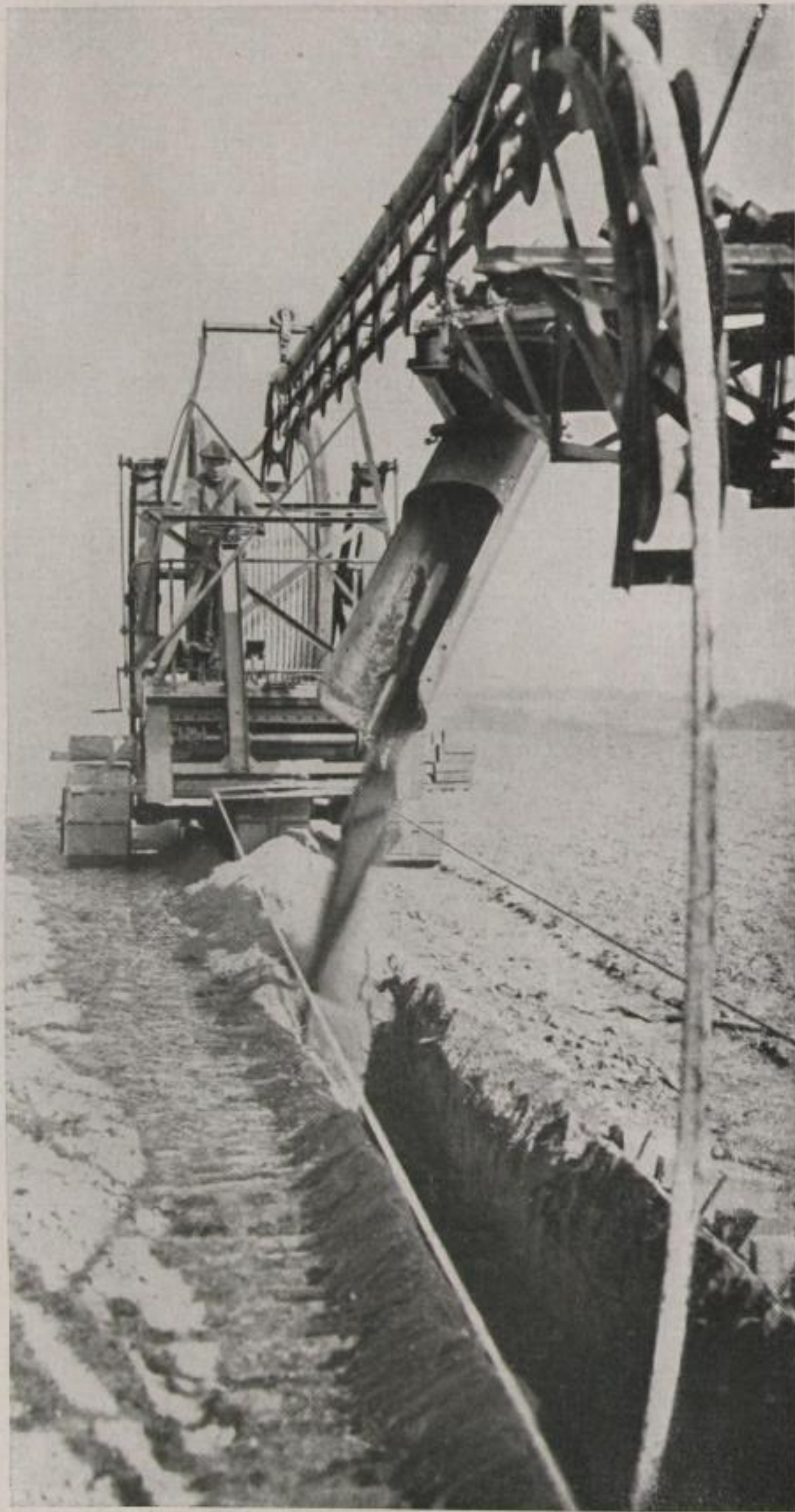
Abb. 4. Kabelverlegung
