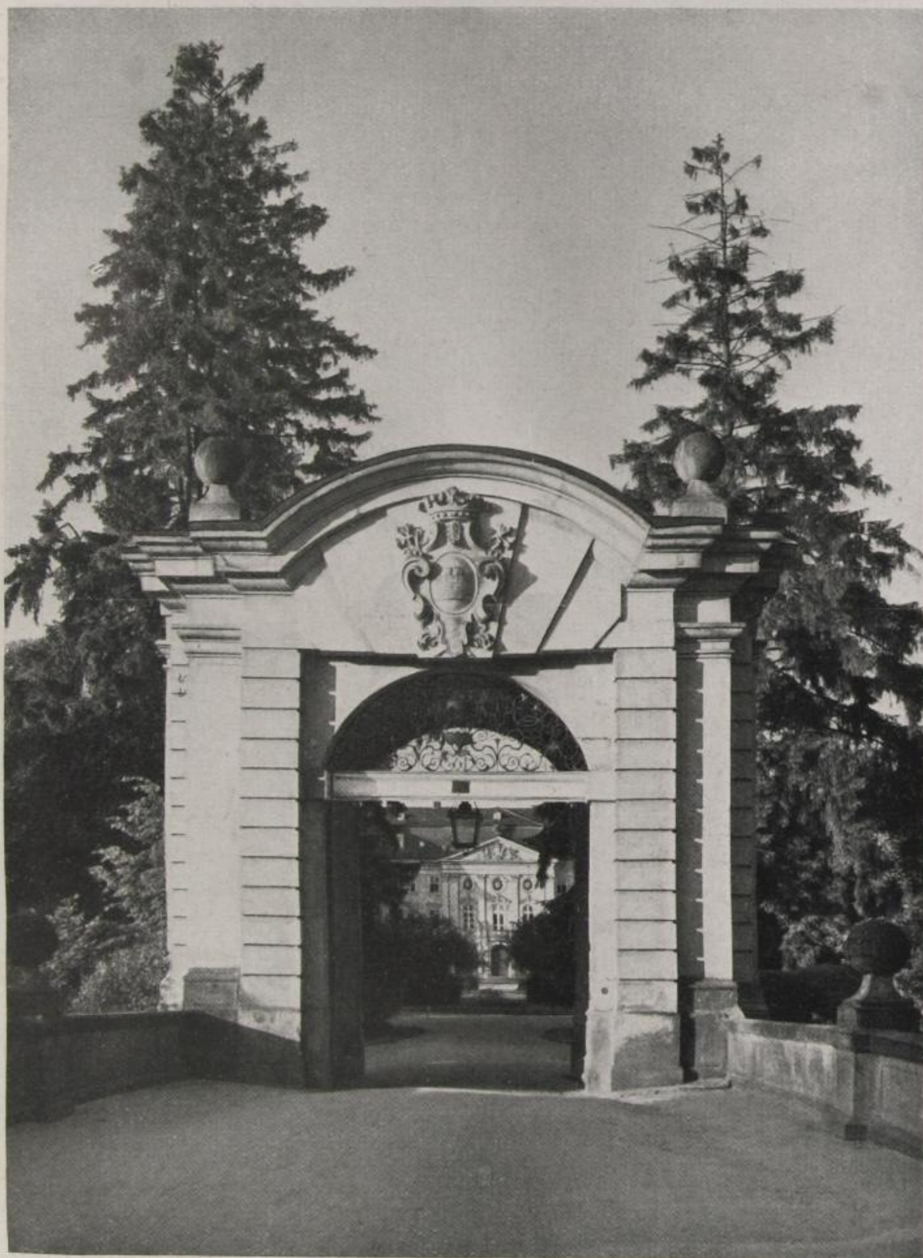
Abb. 4. Portal von außen gesehen (von der Wallgrabenbrücke aus)
