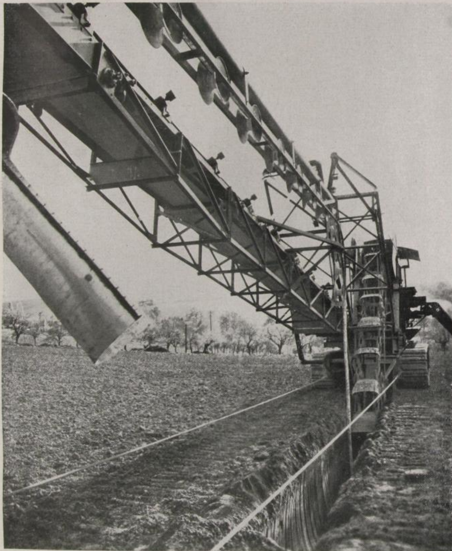
Abb. 2. Der Grabenbagger von der Rückseite
