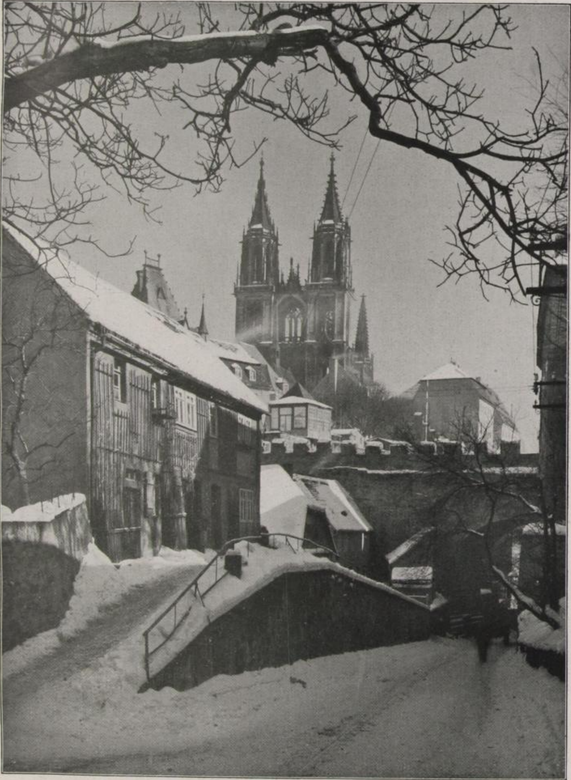
Abb. 10. Blick vom Hohlweg über die Schloßbrücke („Gewölbe“) zum Dom
