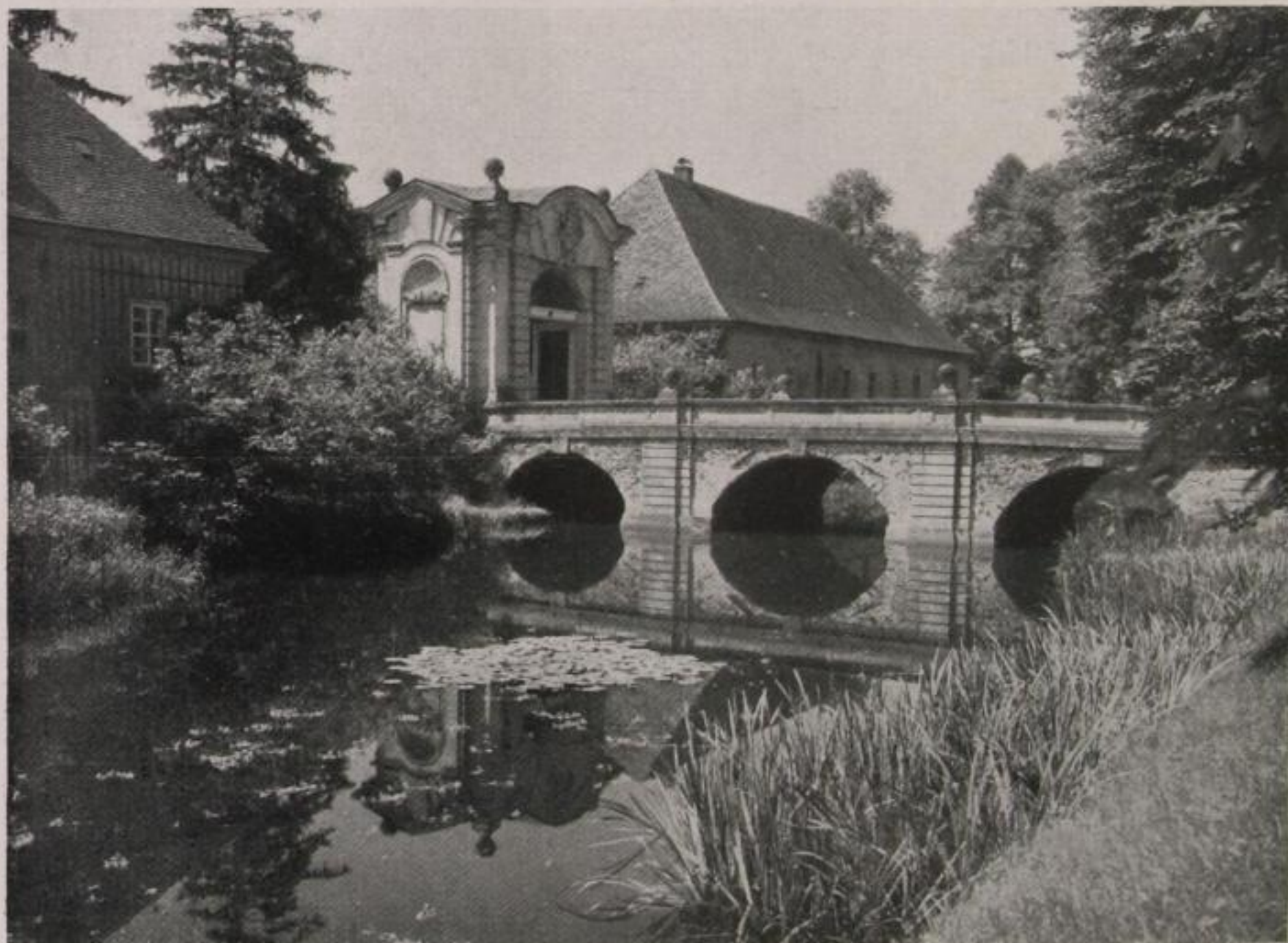
Abb. 3. Wallgrabenbrücke mit Portal (mit Forstmeisterei links und Hausverwaltung rechts) von außen gesehen
