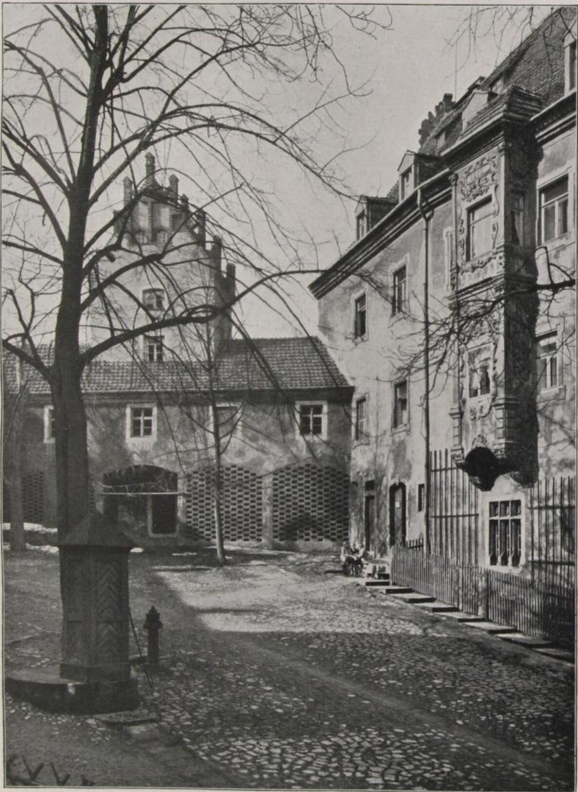
Abb. 1. Der Ökonomiehof der Landesschule St. Afra mit dem Propsteigebäude
