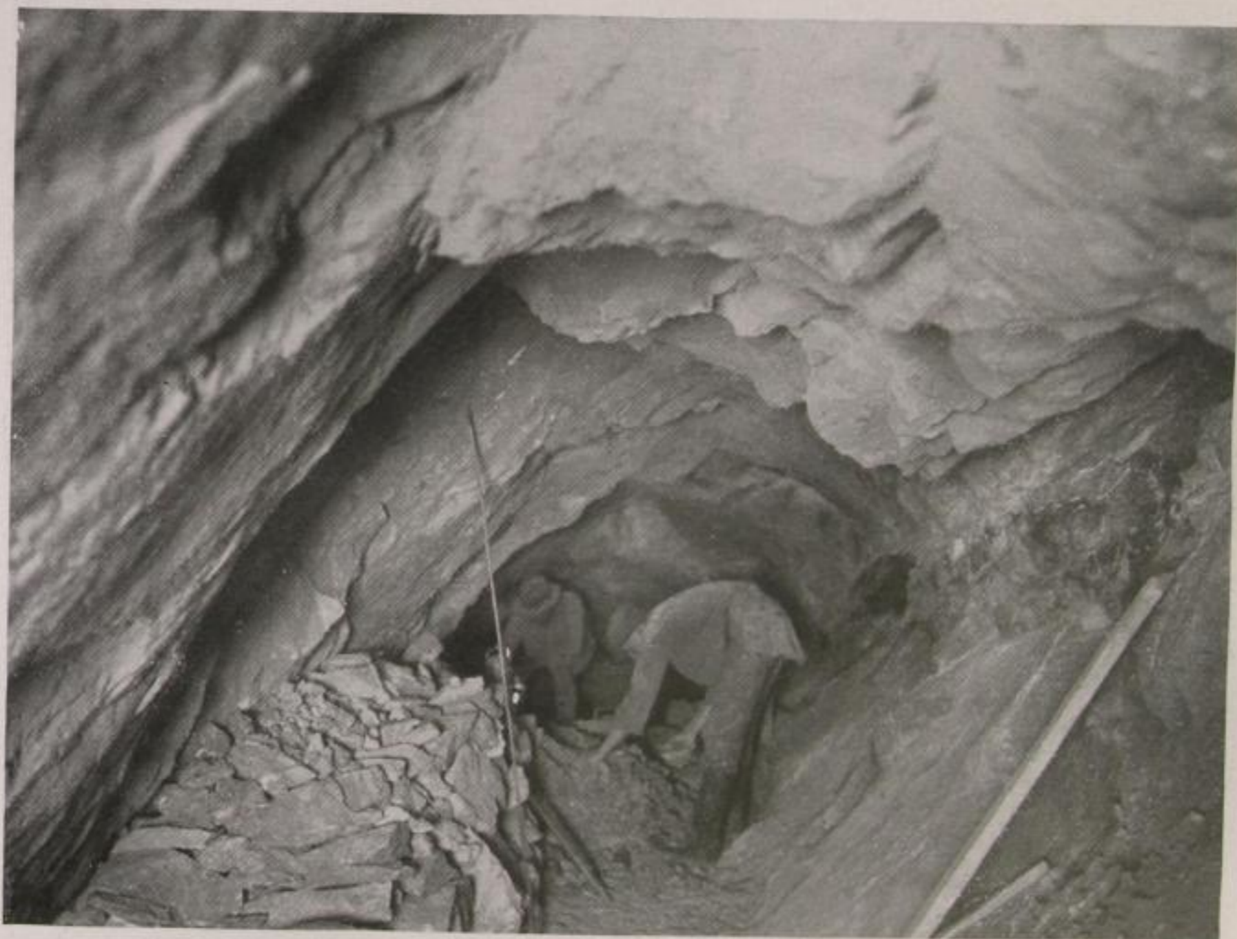
Abb. 12. Firstenbau über zweiter Gezeugstrecke auf Beständigkeiter Morgengang Der Erzgang, rechts deutlich sichtbar, fällt unter etwa 50° ein (nach links unten). Deutlich ist die fortschreitende Erhöhung der Arbeitsstelle durch Aushieb nach rechts oben und Bergeversatz von links unten her erkennbar
