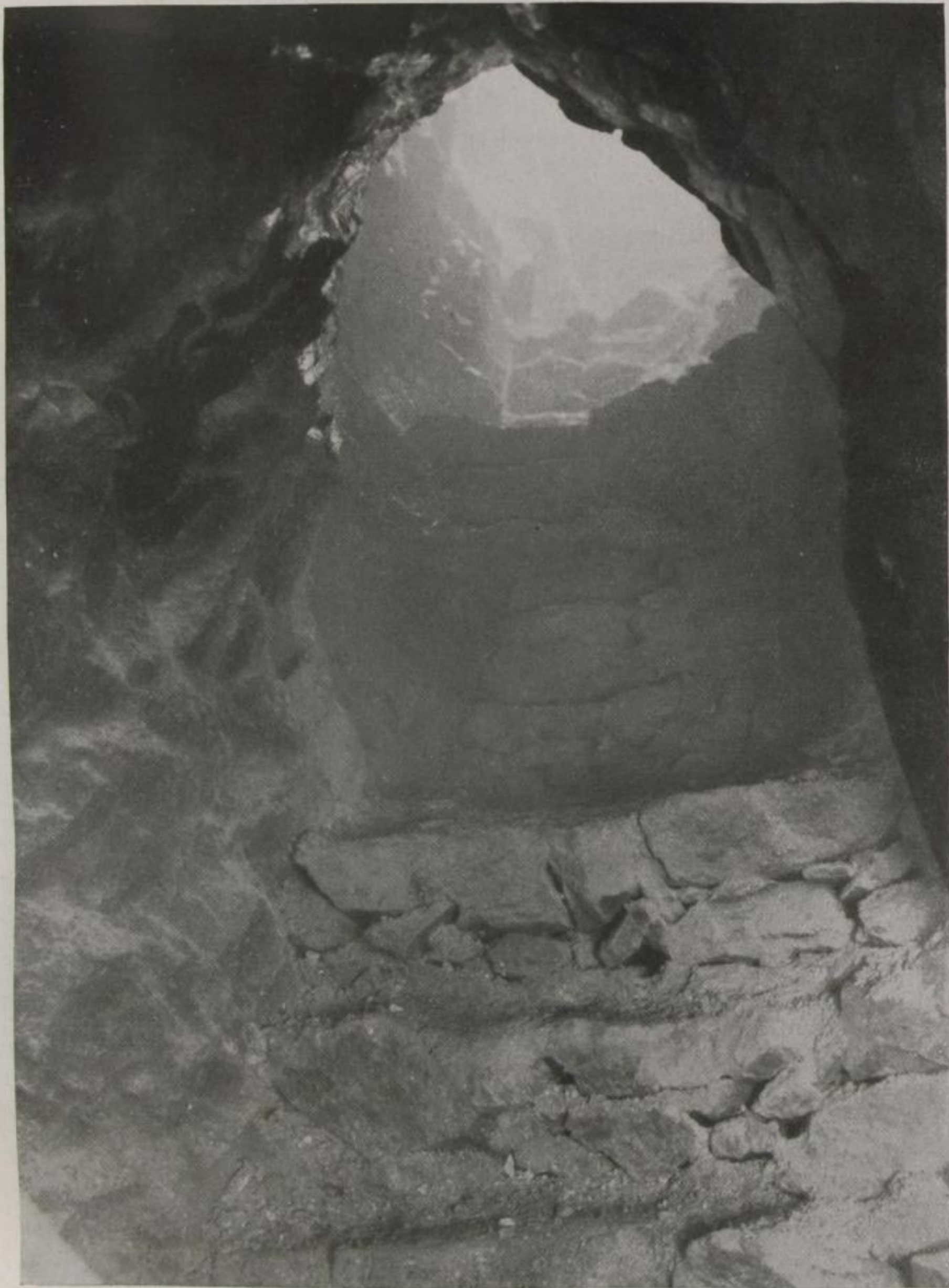
Abb. 11. Firstenbau über zweiter Gezeugstrecke. Derselbe Bau wie in Abb. 10, nur von der andern Seite, so daß der stufenförmige Bergeverfaß sichtbar ist
