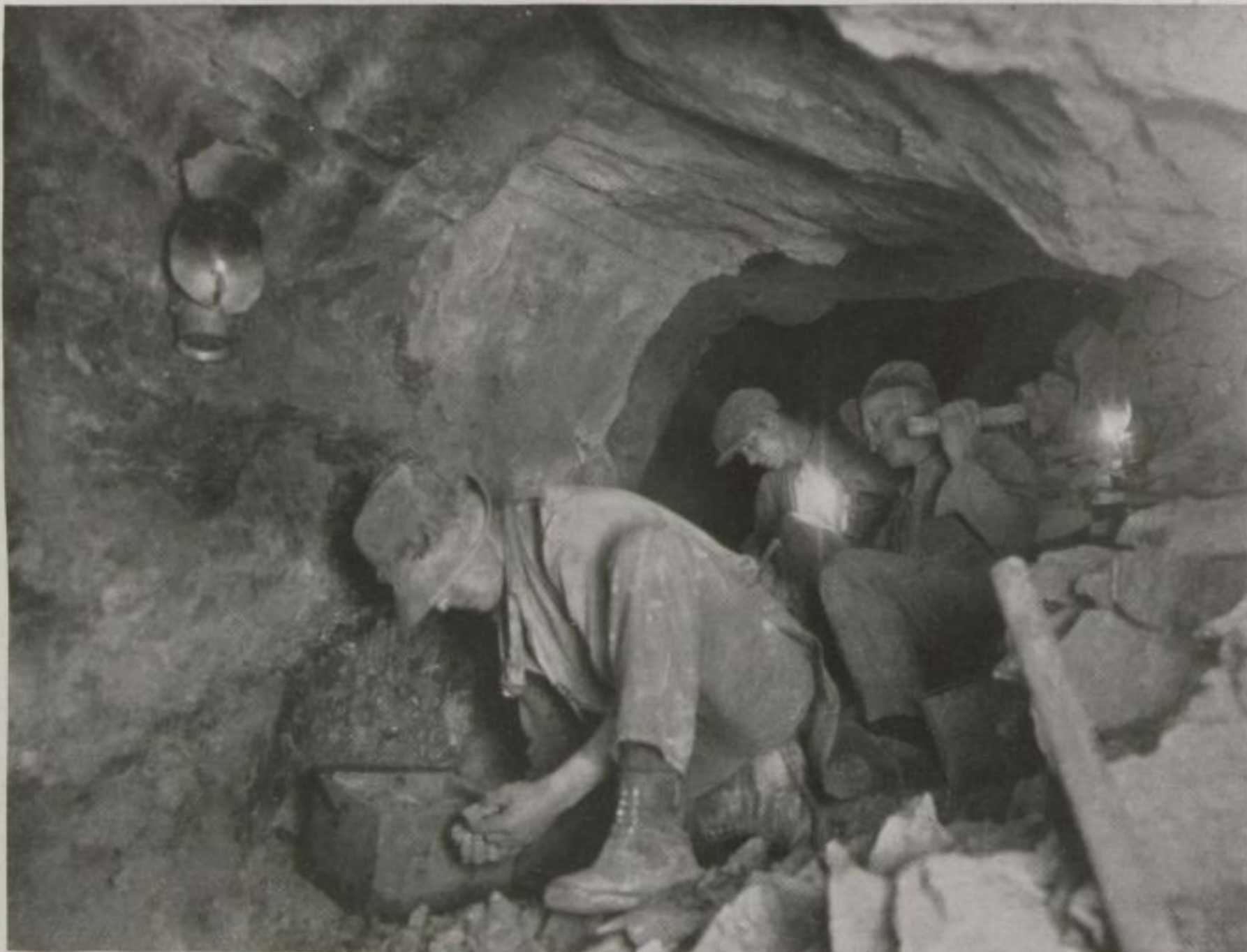
Abb. 13. Firstenbau unter zweiter Gezeugstrecke auf Neuglück Stehendem Der Erzgang (links) fällt sehr flach ein, was sich deutlich am Hangenden (oben) zeigt
