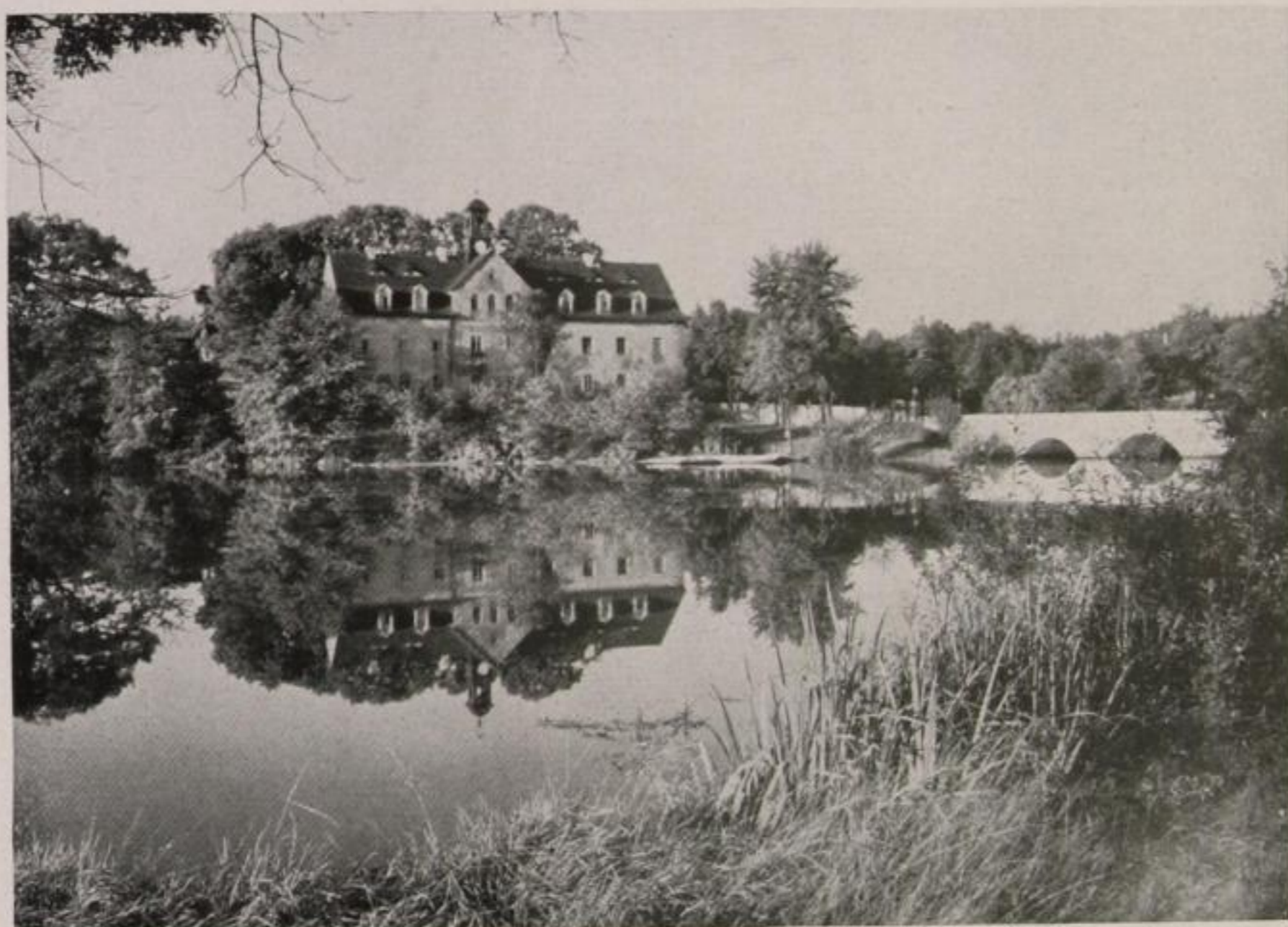
Abb. 29. Grillenburg. Jagdhaus und Brücke
