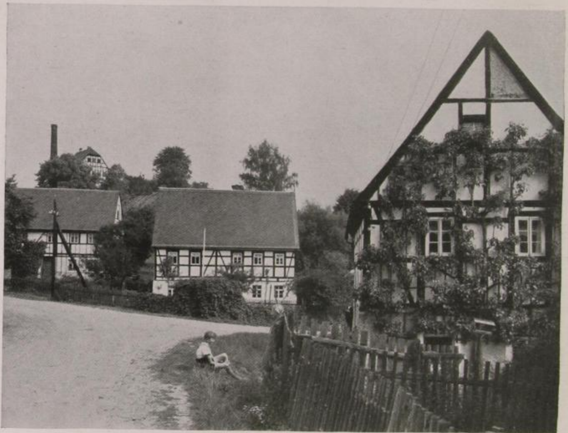
Abb. 2. Selbstbewußt überragt das Treibhaus die Häuser des Dorfes
