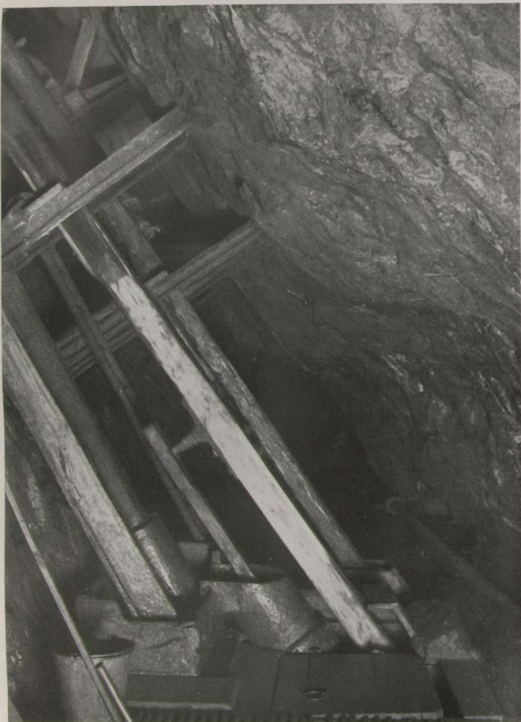
Abb. 5. Saugzylinder und Wasserkasten in der zweiten Gezeugstrecke Rechts die Rohrleitung, die in der vom Schachte wegführenden Gezeugstrecke die Preßluft in die Baue leitet
