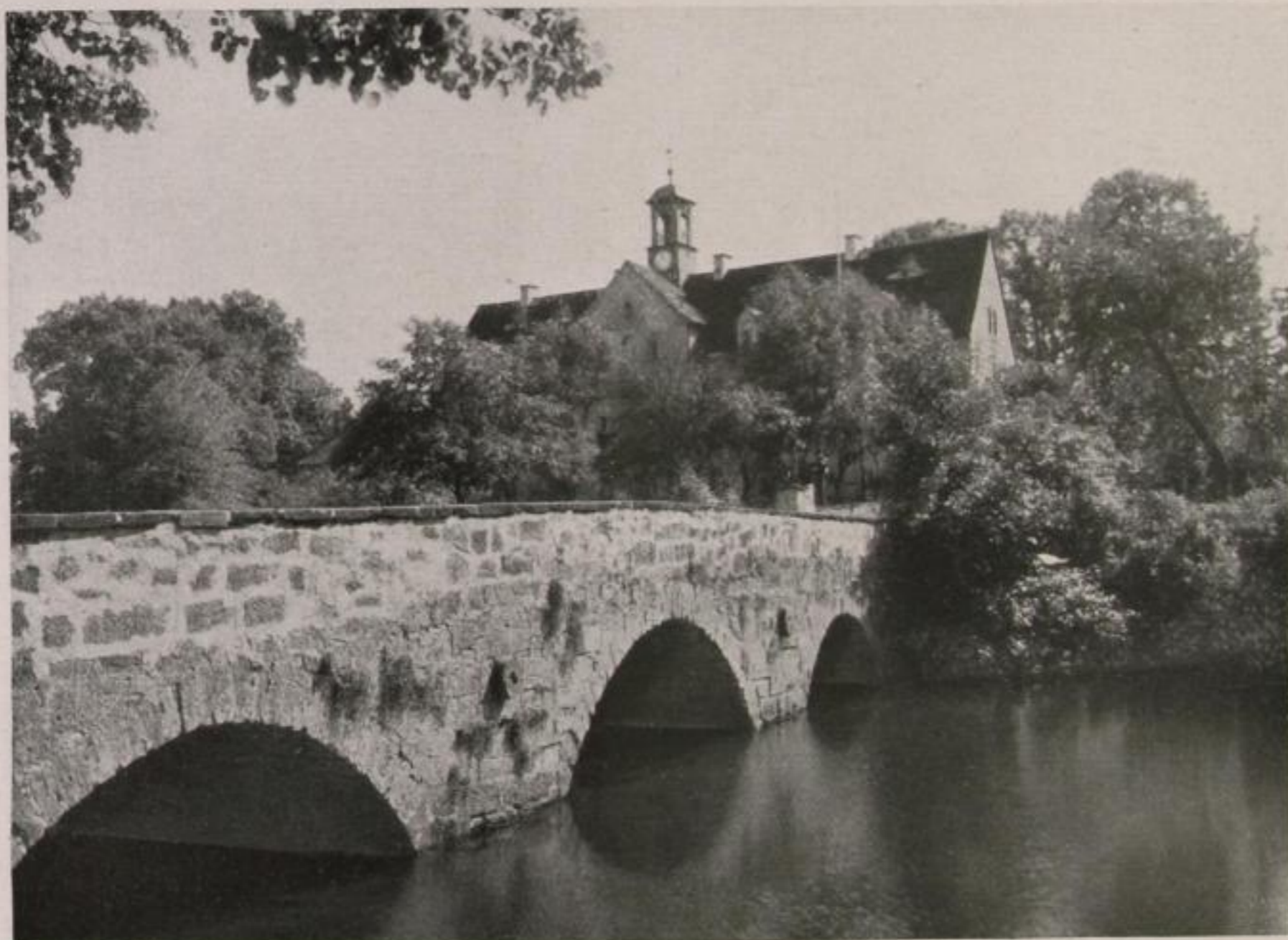
Abb. 9. Grillenburg. Die alte Steinbrücke
