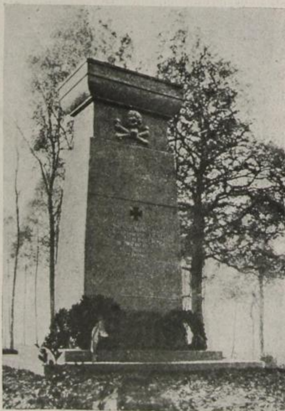
Abbildung 37 Denkmal für die gefallenen Braunschweiger bei Mettel (Belgien).
