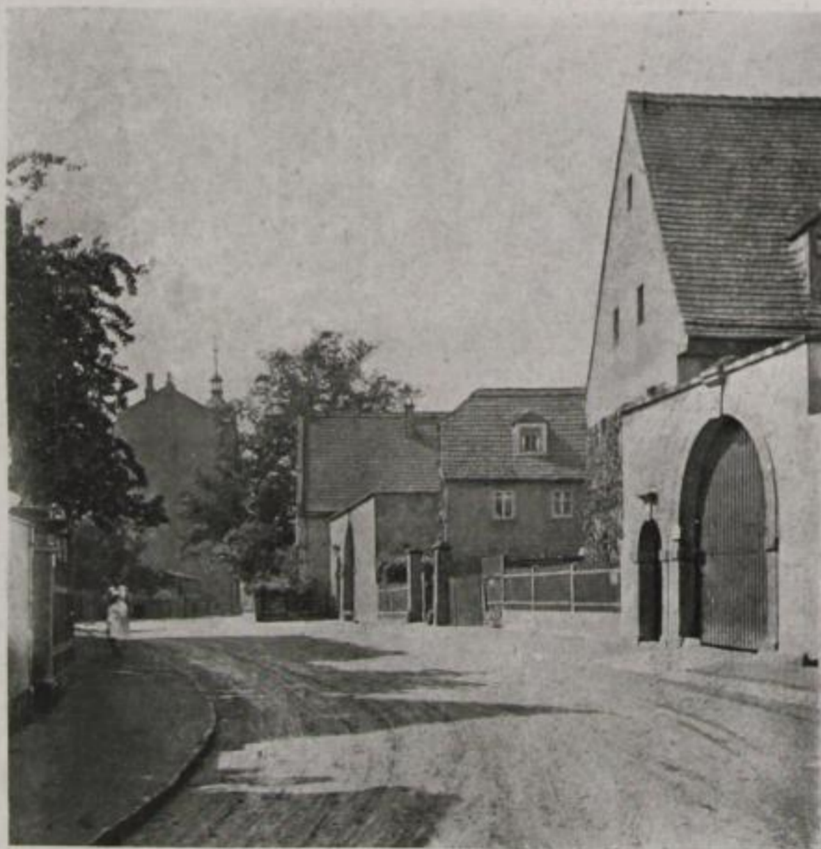
Abbildung 3 Blick durch die Geisingstraße nach der Schandauer Straße
