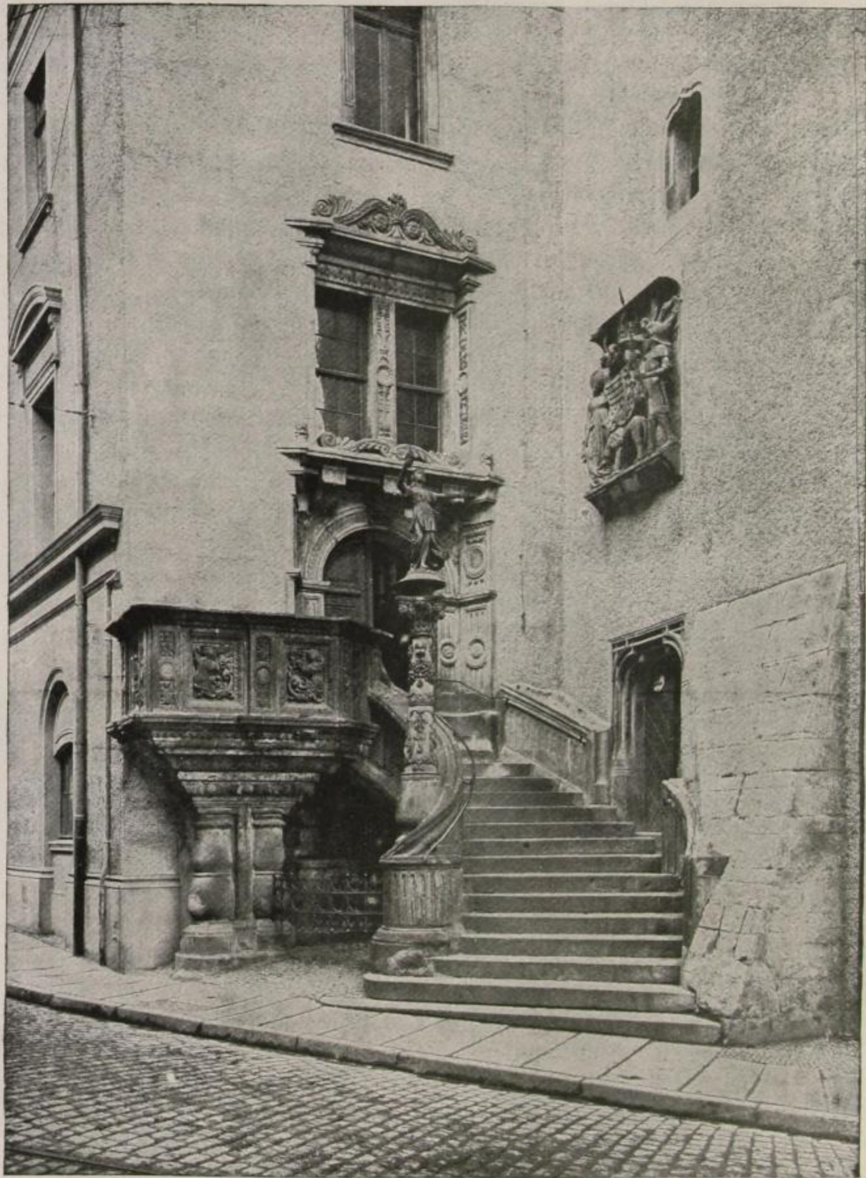
Abbildung 4 Rathhaustreppe in Görlitz
