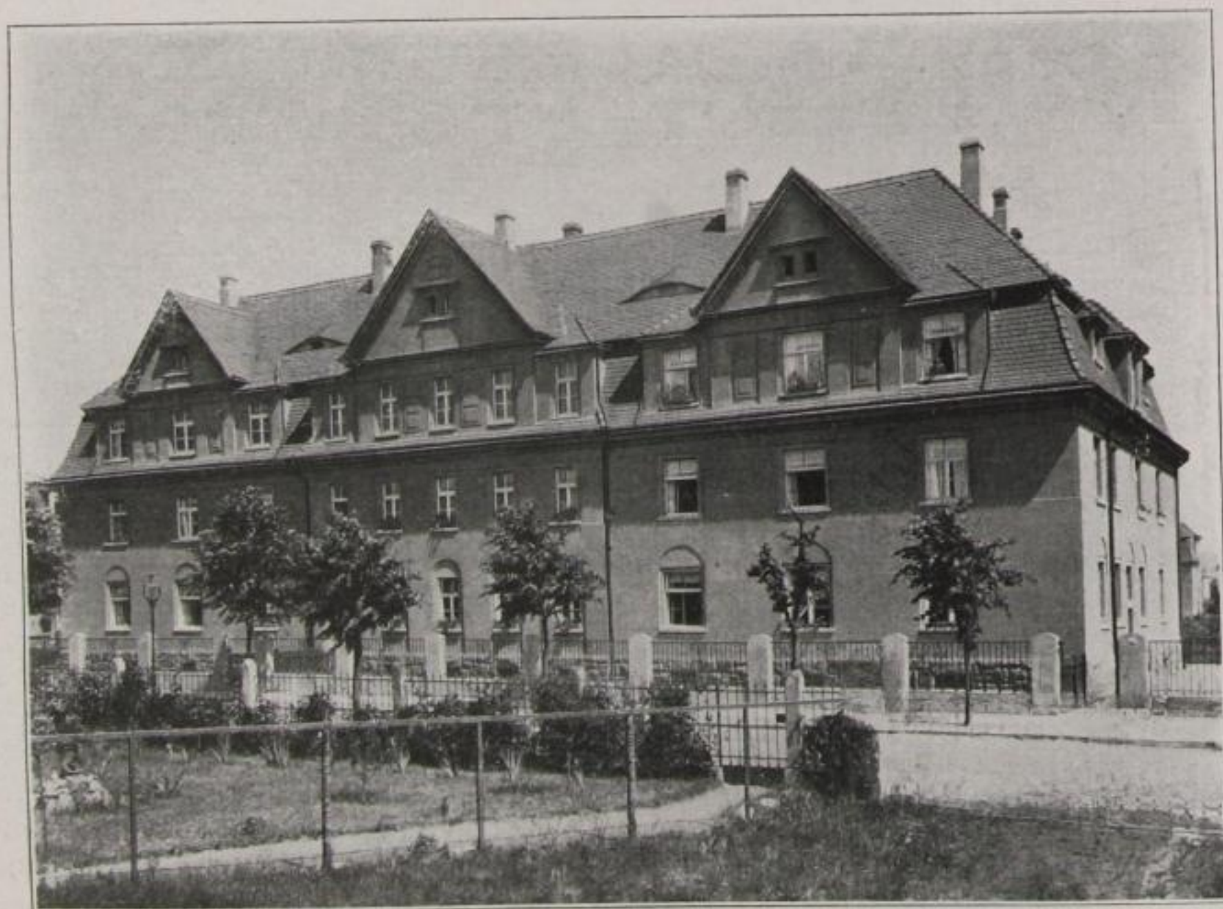
Abbildung 4. Baugenossenschaft Leuben (Amtsh. Dresden-A.)
