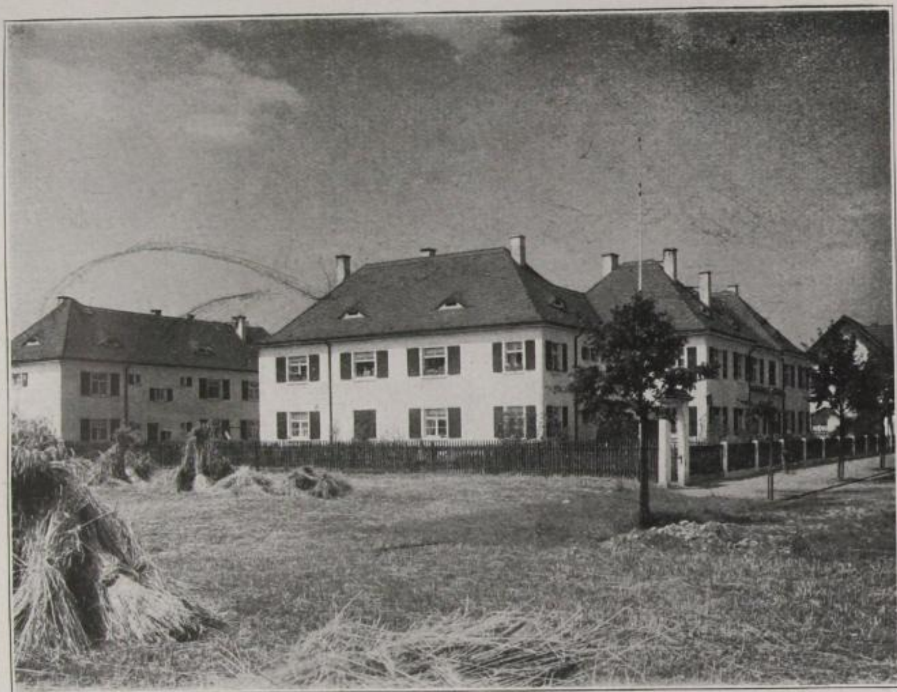
Abbildung 3. Baugenossenschaft f. d. Peri. d. Kgl. S. St.-Eisenb. zu Pirna. Baugruppe Mügeln.
