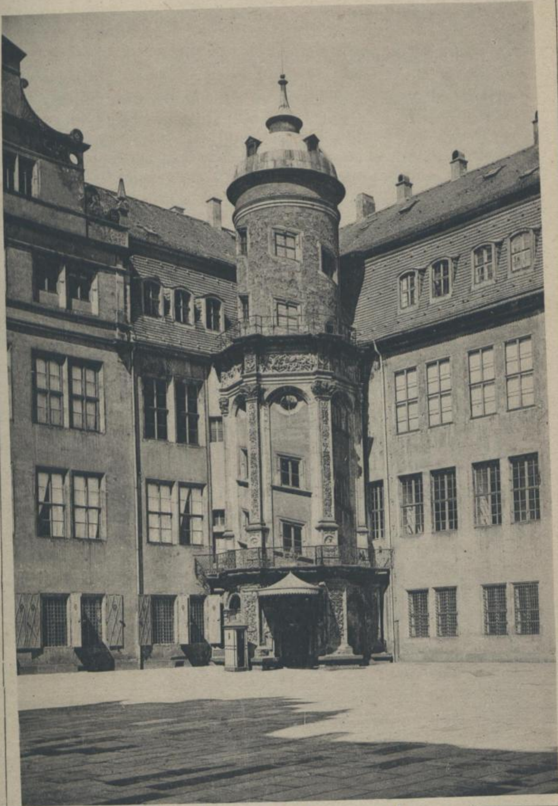
Der nordwestliche Treppenturm.
